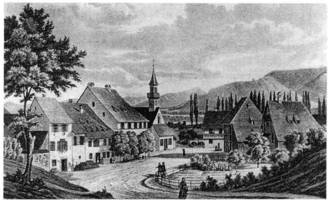
Abb. 3. St. Jakob 1843, nach einer Zeichnung von A. Winterlin. Zwischen dem Wirtshaus (im Hintergrund gegenüber der Kirche, hinter dem Brunnen) und dem Gebäude am rechten Bildrand im Vordergrund steht die Ziegelhütte.
