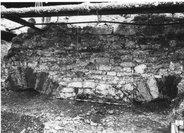
Abb. 6. Steinengraben 41 (A), 1971/30. Mauerfundament mit Entlastungsbogen. Blick gegen Nordosten (vgl. Abb. 1,5).
