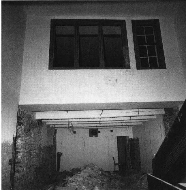
Abb. 5. Phase 5: Hoffassade des Hauptbaus. Die Fassade im 2. Obergeschoss überspannt die gesamte Hausbreite. Sie ist anlässlich der gassenseitigen Erweiterung von Kernbau II entstanden. Beim modernen Ladenumbau wurde der untere Teil der Hoffassade abgebrochen und der obere Teil mit Stahlträgern aufgefangen. – Foto: Basler Denkmalpflege, G 225-10.
