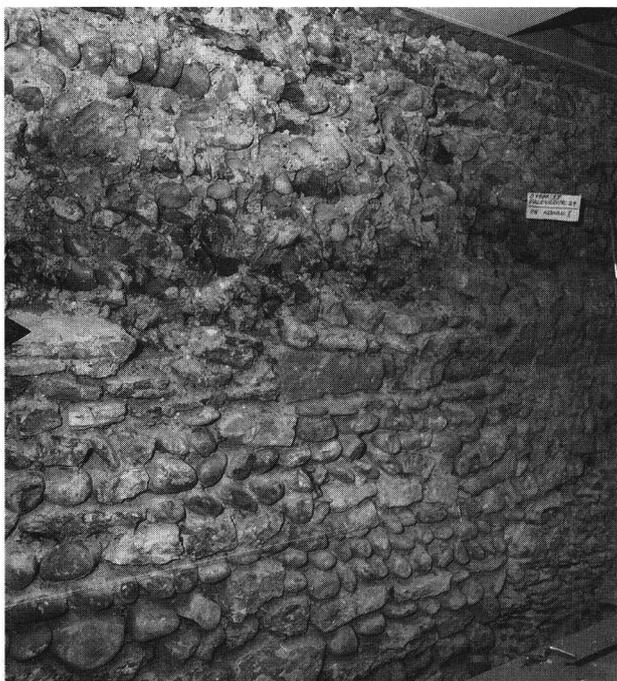
◀ Abb. 11. Phase 3: Innenansicht der Südmauer von Kernbau II im Erdgeschoss. Die freigelegte Mauer, an deren westlichem Ende die birsigseitige Türe eingelassen ist (Abb. 10), lässt den Ansatz des abgebrochenen Gewölbes anhand einer Lage schräg gestellter Steine (Pfeile im oberen Bilddrittel) erkennen. – Foto: Basler Denkmalpflege, G 224-7.
