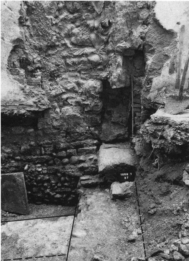
Abb. 10. Phase 3: Ansicht des Türgewändes am westlichen Ende der Südmauer von Kernbau II (siehe Abb. 4,c). Das untere Sandsteingewände und die halbe Schwelle (über der Fotonummer) sind noch in situ; die westliche Fassadenmauer unter der Schwelle sowie die Gangmauer sind angedeutet (Zustand während des Abbruchs). – Foto: AB, 37.
