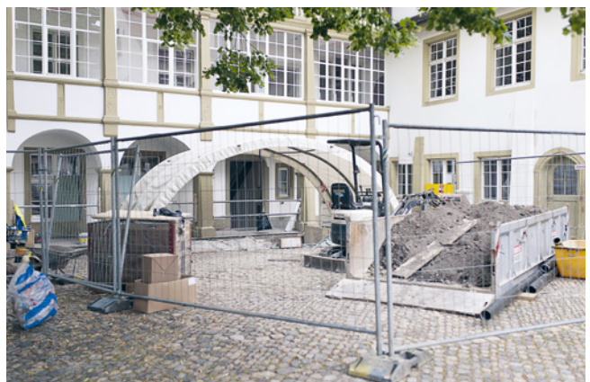
ABB. 10 Der Innenhof des Schulhauses zur Mücke mit dem Aushub für den Kanalisationsanschluss rechts unter dem Zelt. Foto: Philippe Saurbeck.
