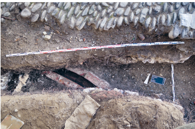
ABB. 14 Unter der Kieselpflasterung und modernen Aufschüttungen ist der aus Backsteinen gemauerte Kanal zu erkennen, links und rechts begleitet von einer schmalen Baugrube. Foto: Michael Weber.
