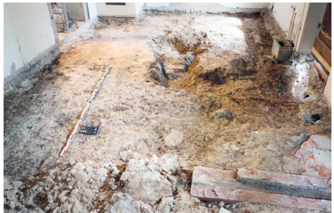
ABB. 42 Die sandsteinerne Abflussrinne mit wenigen Resten des Tonplattenbodens. Foto: Birgit Lißner.
