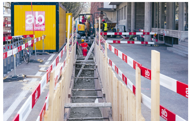
ABB. 15 Der Kanal für die Installation eines Kälteverbundes und einer neuen Stromleitung erstreckte sich ca. 550 m lang vom Bernoullianum bis zum Petersgraben. Foto: Philippe Saurbeck.
