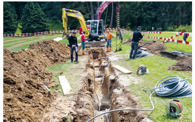
ABB. 34 Für die Erdwärmenutzung wurden im Wenkenpark insgesamt neun ca. 100 m lange Gräben mit Löchern zur Versenkung von Erdkörben angelegt. Foto: Michael Ketzler.
