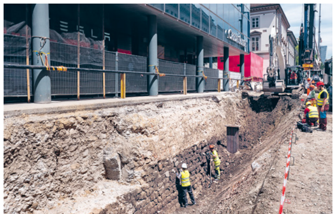
ABB. 13 Unter den Gebäuden nördlich am St. Alban-Graben war die Innere Stadtmauer meist grossflächig erhalten. Sie musste aber streckenweise dem Parkhaus weichen. Foto: Philippe Saurbeck.
