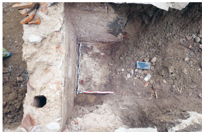
ABB. 28 Blick in die erhalten gebliebene verputzte Kellerecke. Links unten ist in der Mauer eine vierkantige Aussparung sichtbar, in der vermutlich einst ein Holzbalken als provisorische Stütze eine Unterfangung ermöglichte. Foto: Martin Allemann.
