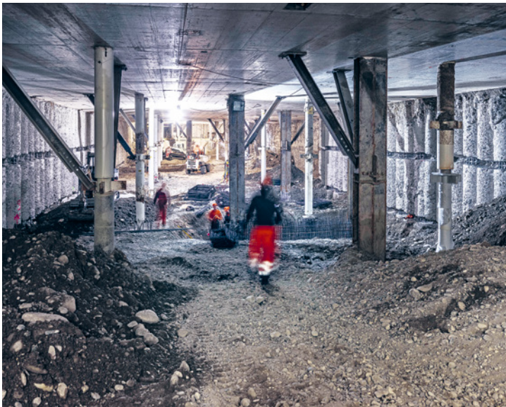
ABB. 2 Nachdem die Decke und die Wände des Parkhauses von der Oberfläche her erstellt waren, erfolgte der Aushub des riesigen Volumens untertägig. Foto: Philippe Saurbeck.
