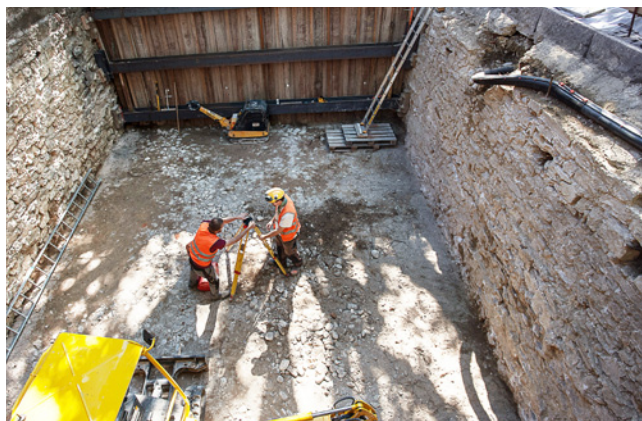
ABB. 24 Ansicht der Innenseite der Äusseren Grabenwallmauer, die sich direkt unter den Trottoirrandsteinen des Klingentalgrabens befindet. Foto: Margit Dauner.
