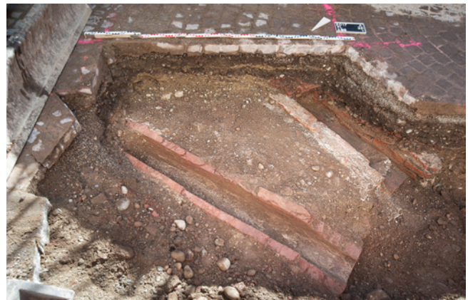
ABB. 6 Blick auf zwei frühneuzeitliche Dachwasserkanäle aus Sand- und Backsteinen. Sie leiteten Meteorwasser von der Liegenschaft Münsterplatz 11 (Falkensteinerhof) ab. Foto: Sven Billo.
