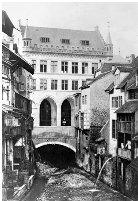
ABB. 20 Auf der historischen Abbildung ist gut erkennbar, wie bei der Liegenschaft Falknerstrasse 5 (2. Haus rechts) die Abwässer in den offenen Birsig geleitet werden. Foto: Denkmalpflege Basel-Stadt.
