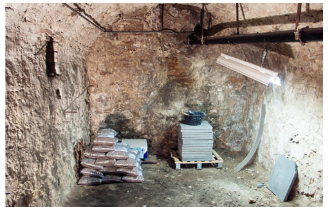
ABB. 14 Keller mit den Spitzbogennischen und dem sekundären Gewölbe. Foto: Norbert Spichtig.
