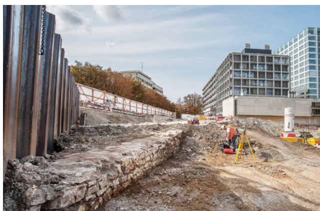
ABB. 34 Die Innenseite der Eisenbahnmauer im Fundamentbereich. Foto: Philippe Saurbeck.
