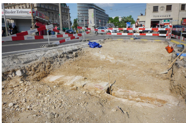
ABB. 13 Der aus Kalkbruch- und roten Sandsteinen gebaute Kanal ist mit Steinplatten abgedeckt. Er befindet sich noch heute unter der Kreuzung beim Aeschensplatz. Foto: Susan Steiner.
