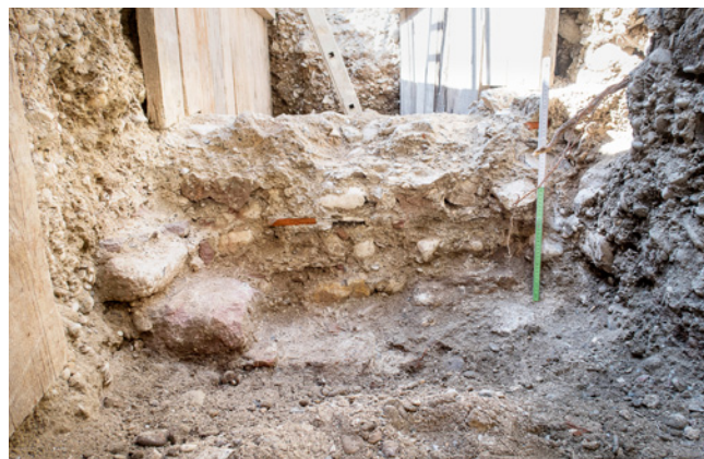
ABB. 44 Im Leitungsgraben werden Reste der Kontermauer von der Äusseren Stadtmauer aus dem 14. Jahrhundert freigelegt. Foto: Birgit Lißner.
