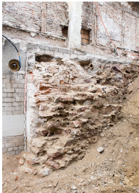
ABB. 18 Von der historischen Bebauung konnten sich im Parzellenrandbereich Keller- und Fachwerkwandreste erhalten. Foto: Birgit Lißner.
