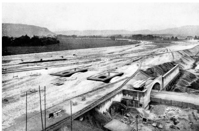
ABB. 45 Blick vom Uhrturm des Empfangsgebäudes auf die südliche Aufschüttung des Personenbahnhofs. Im Vordergrund die Überführung über die Riehenstrasse. Foto: Denkmalpflege Basel-Stadt.
