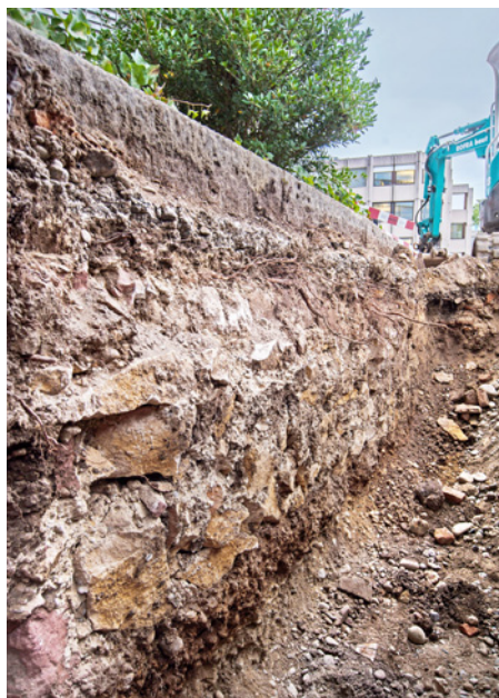
ABB. 30 Ansicht des freigelegten Gartenmauerfundaments. Foto: Sven Billo.
