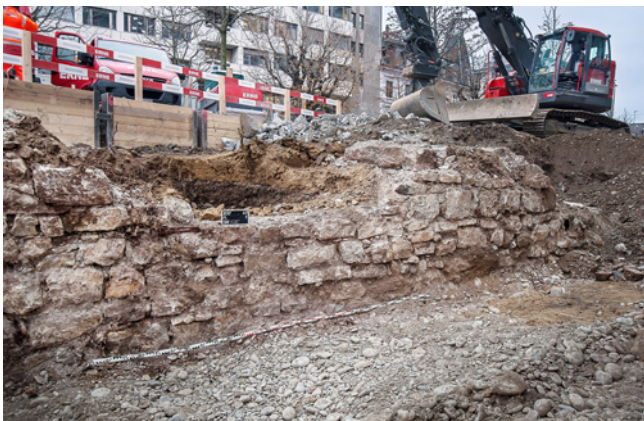
ABB. 49 Blick in Richtung Klingelbergstrasse. Neben der Aussenseite der Eisenbahnmauer konnte auch ein kurzes Stück der Innenseite dokumentiert werden. Foto: Sven Billo.
