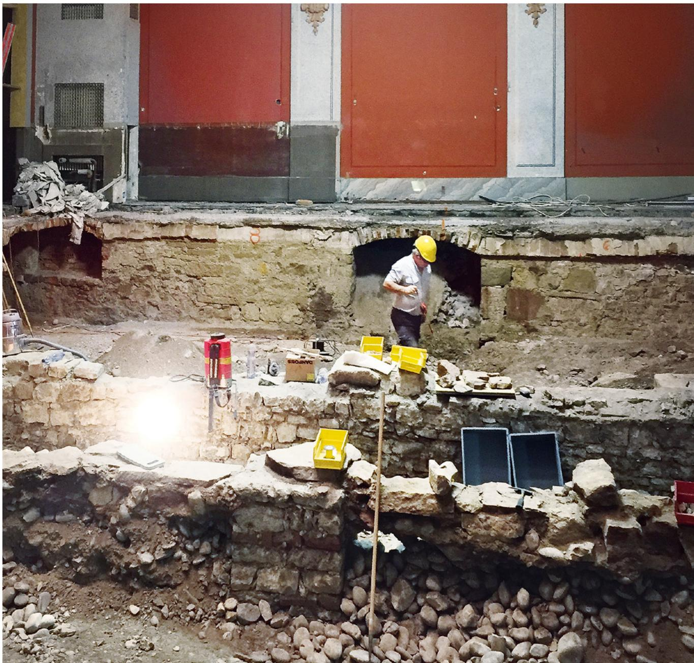
ABB. 9 Bereits einen halben Meter unter dem Konzertsaalboden wurden erste Befunde aufgedeckt: Die hofseitige Mauer des Verwaltungsgebäudes des Kaufhauses und ein Punktfundament der Pfeilerkolonnade. Foto: Guido Lassau.
