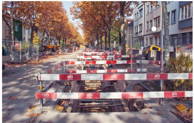
ABB. 20 Blick nach Norden in die Schwarzwaldallee. Der geöffnete Graben gehört zur Wasserleitung von 1914/1915, die ersetzt wurde. Foto: Christian Stegmüller.
