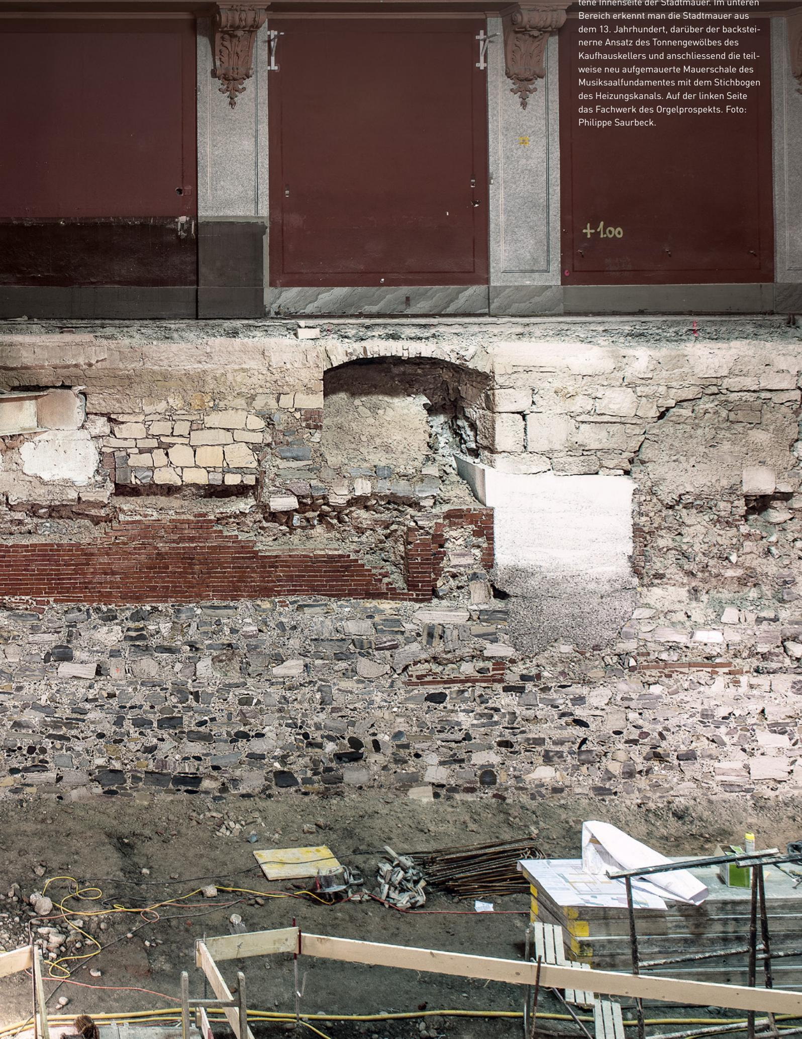
ABB. 23 Blick auf die bereits zurückgeschnittene Innenseite der Stadtmauer. Im unteren Bereich erkennt man die Stadtmauer aus dem 13. Jahrhundert, darüber der backsteinerne Ansatz des Tonnengewölbes des Kaufhauskellers und anschließend die teilweise neu aufgemauerte Mauerschale des Musiksaalfundamentes mit dem Stüchbogen des Heizungskanals. Auf der linken Seite das Fachwerk des Orgelprospekts. Foto: Philippe Saurbeck.
