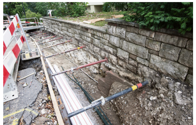
ABB. 43 Übersicht nach Norden; die heutige Gartenmauer steht auf der Flucht der Kontermauer der St.-Alban-Schanze, von deren Verblendung im Vordergrund rechts Sandsteinquader sichtbar sind, und nutzt sie als Fundament. Foto: Christian Stegmüller.
