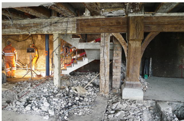
ABB. 1 Übersicht Richtung Rheinsprung im 3. UG: Im Vordergrund Holzbauteile der Kornschütte, im Hintergrund Bohrarbeiten zur Sicherung. Foto: Martin Allemann.
