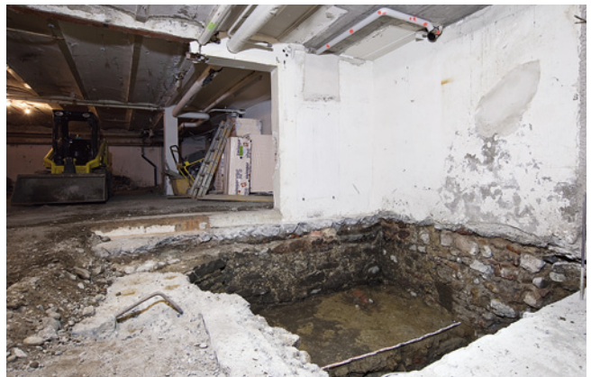
ABB. 27 Die Reste des südlichen Vorgängerbaus der heutigen Liegenschaft Freie Strasse 59, die nur entlang der südlichen Aussenmauer erhalten waren: Zur Strasse hin war nur noch eine mächtige moderne Auffüllung vorhanden. Foto: Christian Stegmüller.
