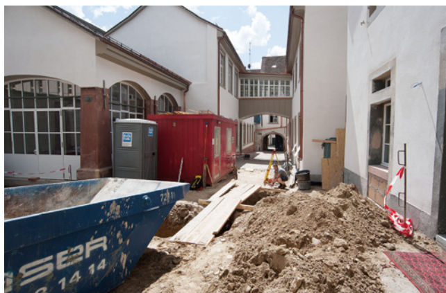
ABB. 24 Blick durch die Liegenschaft hindurch zur Rheingasse (hinter der Tordurchfahrt); die bronzezeitliche Keramik fand sich unter den Brettern im Mittelgrund. Foto: Benedikt Wyss.
