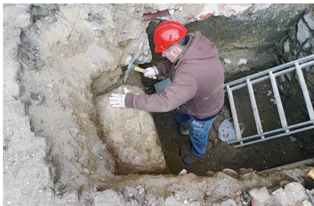
ABB. 8 Roman Rosenberger beim Freilegen des Mörtelbetts. Foto: Marco Bernasconi.
