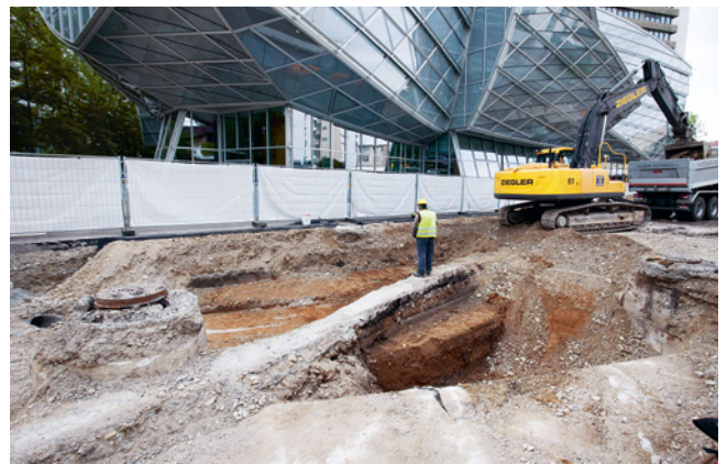
ABB. 31 Abtrag der modernen Deckschichten bis auf die intakte archäologische Schicht vor dem prominenten Novartisgebäude des Architekten Frank O. Gehry. Foto: Margit Dauner.
