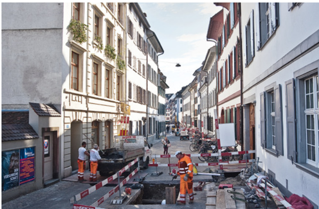
ABB. 26 Blick nach Süden in den Nadelberg hinein; im Nordprofil der Fläche im Vordergrund waren zwischen vielen modernen Gräben noch wenige mittelalterliche Schichtreste zu erkennen. Foto: Michel Woerner.
