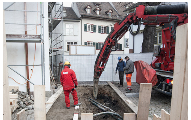
ABB. 9 Der Saugbagger im Innenhof des Schulhauses zur Mücke. Foto: Christian Stegmüller.
