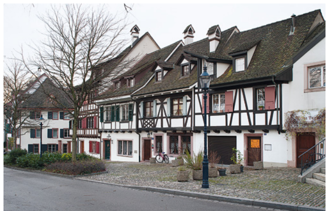
ABB. 19 Die Äussere Stadtmauer verlief – nur durch das schmale Platzgässlein getrennt – ehemals direkt vor dieser Häuserzeile am Spalengraben. Foto: Philippe Saurbeck.
