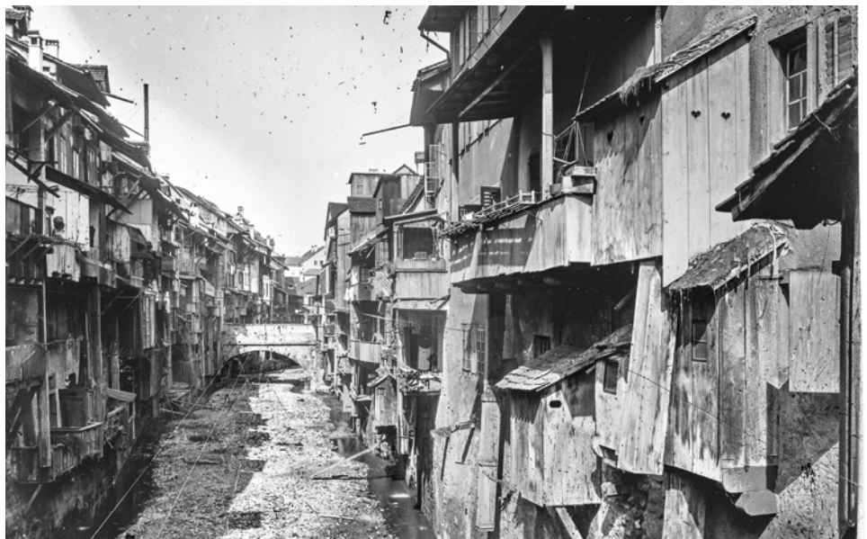
ABB. 4 Die Fotografie des Birsigs zwischen Barfüsserplatz und Post, der als offener städtischer Abwasserkanal diente, vermag einen Eindruck der prekären hygienischen Verhältnisse liefern. Foto: Varady & Cie, StABS NEG A 1098.
