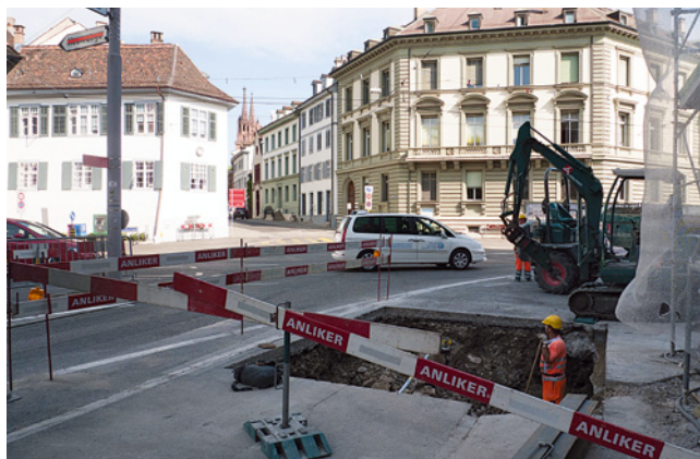
ABB. 41 Blick auf die stark befahrene Kreuzung Dufourstrasse – St. Alban-Graben; im Vordergrund einer der zahlreichen kleinflächigen Bodeneingriffe, die stark modern gestörte Befunde zur neuzeitlichen Vorgängerbebauung ergaben, über welche die heutige Dufourstrasse verläuft. Foto: Martin Allemann.
