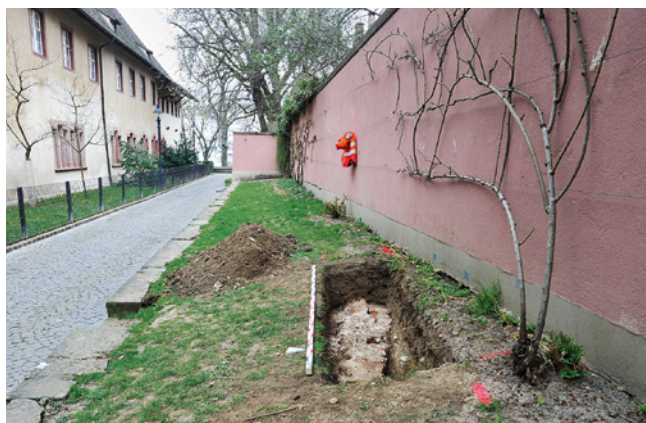
ABB. 16 Mauerfundament des Ertrunkenenfriedhofs am Klingentalweglein. Foto: Christian Stegmüller.
