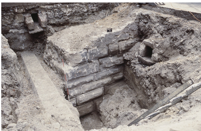
ABB. 28 Die 1998 freigelegte Fortsetzung des Fundaments mit bossierten Quadern. Foto: Catrin Glaser.
