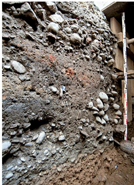
ABB. 2 Nordprofil mit anstehendem Kies, Grabenwandung, Verfüllschichten und Strassenkörper.
