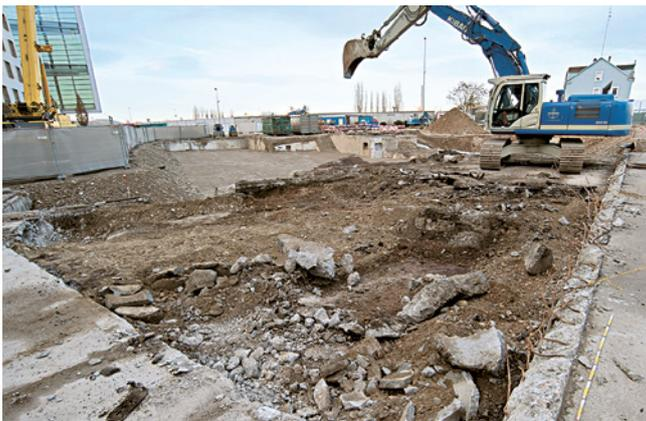
**ABB. 37** Maschineller Abtrag der modernen Einbauten und Auffüllungen entlang der bereits bodeneben rückgebauten Arealmauer. Foto: Benedikt Wyss.
