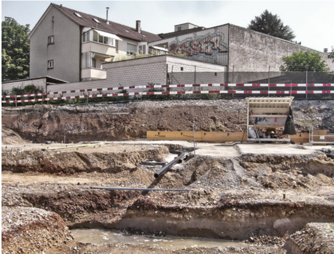
Abb. 41 Blick in die Baugrube. Die hinten sichtbaren Baugrubenwände bestehen zum grössten Teil aus modernen Anschüttungen. Foto: Christoph Matt.
