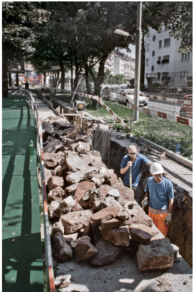
Abb. 42 Fundsituation an der Hegenheimerstrasse: Der Planierungsschutt liegt neben dem Leitungsgaben. Foto: Christoph Matt.
