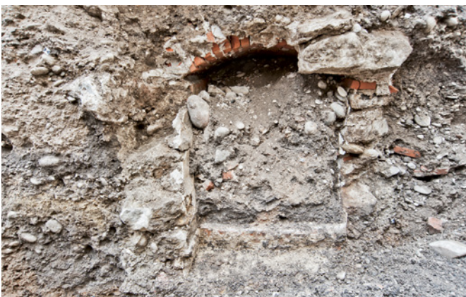
Abb. 7 Die Stapfelberg-Dole kommt aus der Liegenschaft Martinsgasse 11, quert die Gasse und mündet in den namensgebenden Stapfelberg. Foto: Laura Bustamante.
