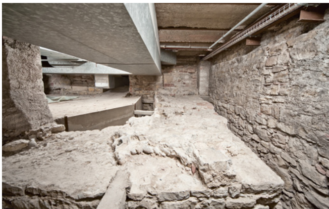
Abb. 19 Blick auf die massive, ehemals wohl eingewölbte Apsis vermutlich eines Vorgängerbaus der romanischen Klosterkirche. Foto: Christian Stegmüller.
