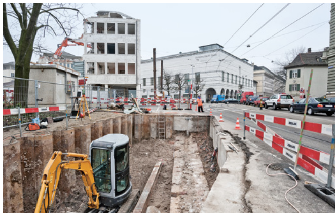
Abb. 16 Blick über die aufgefundene «Doppelmauer»: Kontermauer des inneren Stadtgrabens (rechte Front) und Mauer eines im 19. Jh. daran angebauten Gebäudes (linke Front). Der «Burghof», an dessen Stelle das neue Kunstmuseum entstehen soll, ist bereits zum grossen Teil abgebrochen. Foto: Christian Stegmüller.
