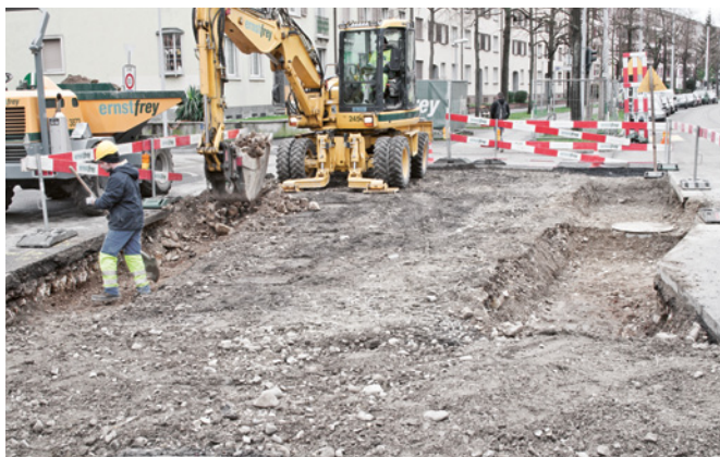
Abb. 38 Unter der entfernten Strassenkoffierung zeichnet sich in der Bildmitte das helle Band des mit Wandkies verfüllten Kanalisationsleitungs-Grabens ab, während in den übrigen Bereichen Abbruchschutt von Gebäuden des 19. Jh. liegt. Foto: Christoph Matt.
