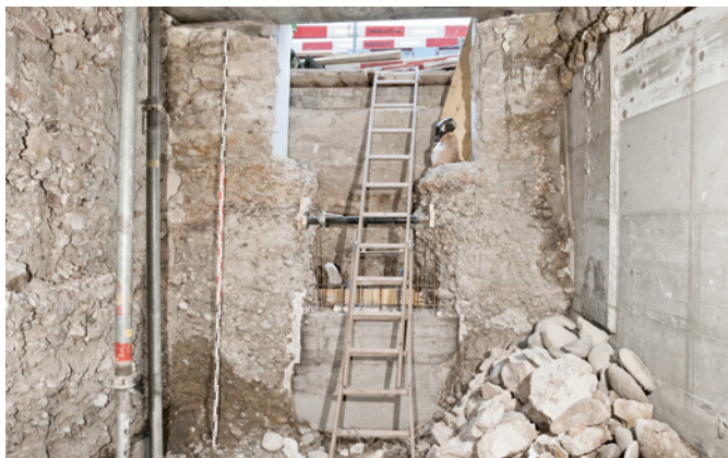
Abb. 15 Blick in den neuen Keller Richtung Strasse. Die wenigen Steinlagen der modern unterfangenen Brandmauer (rechts) könnten noch ins Mittelalter zurückreichen. Die Kellermauer (links) datiert ins 19. Jh. Foto: Christian Stegmüller.
