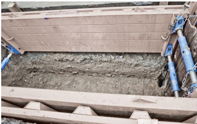
Abb. 35 In einem engen Kanalisationsgraben wird der Profilaufschluss dokumentiert. Foto: Norbert Spichtig.
