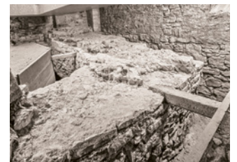
Abb. 5 Apsisfundament des ältesten bisher nachgewiesenen Vorgängerbau der St. Alban-Kirche (9. Jahrhundert?). Foto: Philippe Saurbeck.
