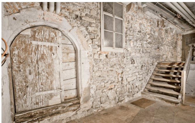
Abb. 17 Die vom Putz befreite Burkhardtsche Stadtmauer mit den nachträglich eingebrochenen Tür- und Fensteröffnungen. Foto: Christian Stegmüller.
