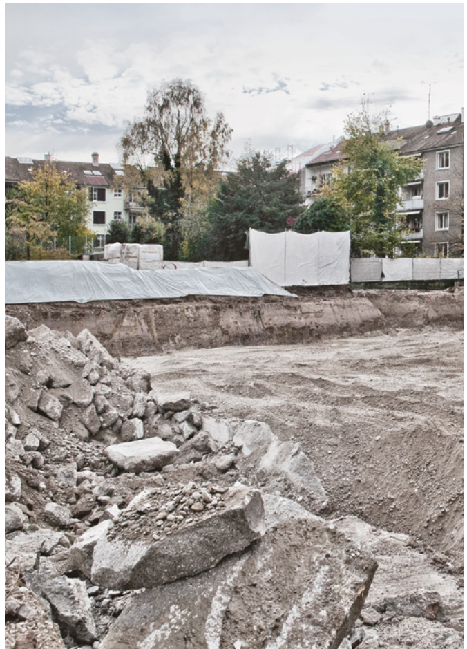
Abb. 45 Blick in die riesige Baugrube. Foto: Christoph Matt.
