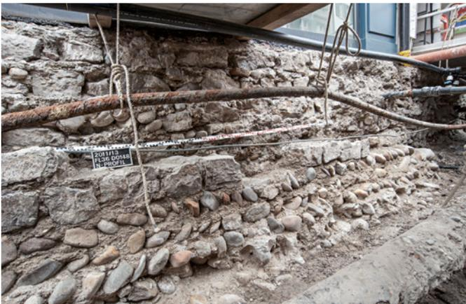
**Abb. 14** Das den Häusern Spalenberg 58/60 vorgelagerte Fundament des Kernbaus (unten). Zurückversetzt (über dem Massstab) liegen die jüngeren aktuellen Hausfundamente. Foto: Christian Stegmüller.
