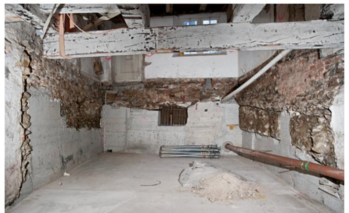
**Abb. 26** Der Keller im Rohbau. Die Fundamente sind deutlich zu sehen (vorne die Fassade mit der Haustüre). Foto: Christian Stegmüller.
