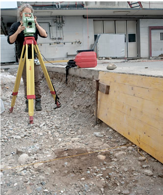
**Abb. 47** Vermessungsarbeiten mittels Tachymeter für die Dokumentation einer kleinen Eintiefung, die sich im natürlichen Kies recht klar abzeichnet.
