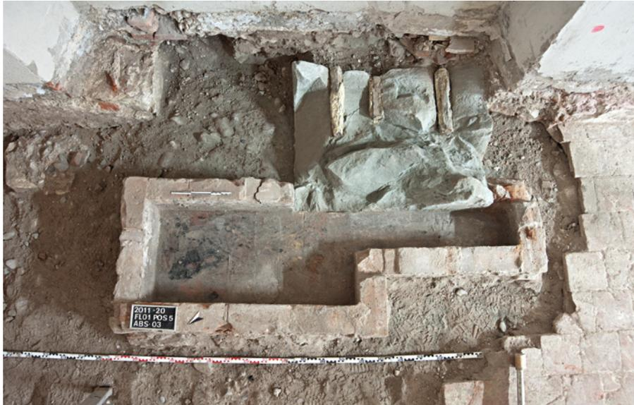
**Abb. 12** Nach dem Entfernen eines Bodenniveaus kam ein grosser Sandsteinblock zum Vorschein. Darin waren in Bohrlöchern mit einer Kittmasse Eisenstäbe befestigt und aus Backsteinen war ein Becken an den Sandsteinblock angebaut. Foto: Jan Baur.
