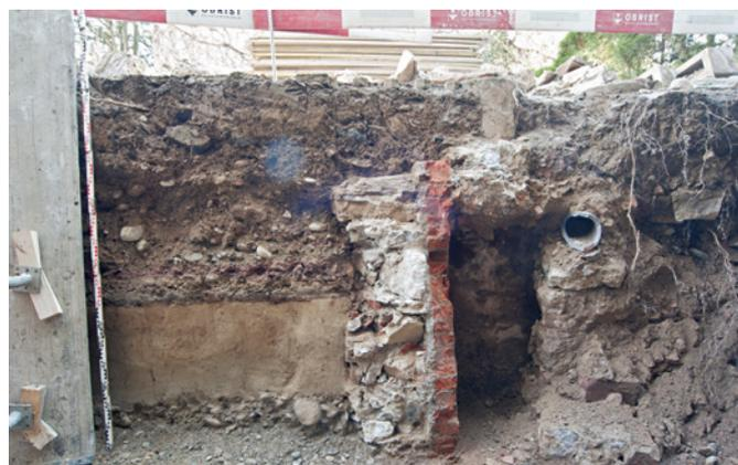
**Abb. 51** Die Baugrubenwand im Hinterhof mit dem in Schwemmsand und glazialen Kies eingetieften Abwasserschacht. Foto: Christoph Matt.
