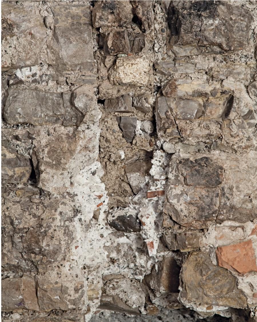
**Abb. 7** Verfülltes Negativ eines Unterfangungs-Pfostens in der Stützmauer im Bereich des alten Hofes des Hauses «zum weissen Bären». Der Befund zeigt die traditionelle Technik der Unterfangung. Foto: Conradin Badrutt.
