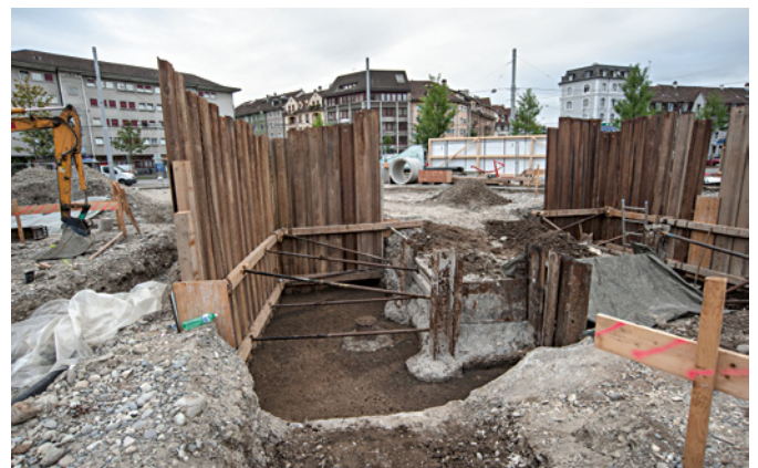
Abb. 65 Hinter Larsen und zwischen Bauspriessen: die Grabungsfläche rund um den Notausstieg des Nordtangente-Tunnels auf dem Gelände des künftigen Robi-Spielplatzes; im Hintergrund der Voltaplatz. Foto: Michael Wenk.
