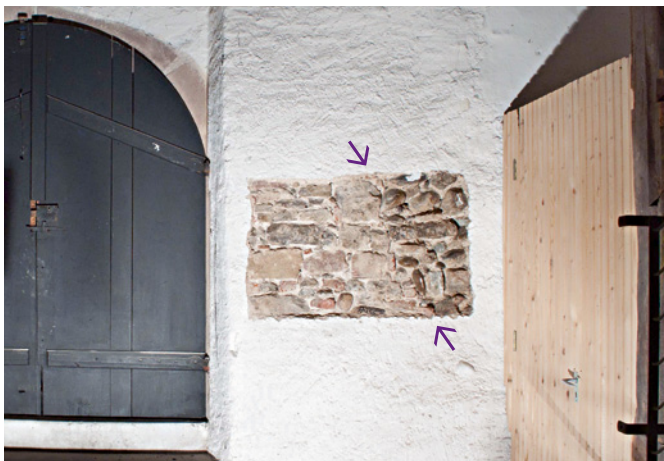
Abb. 46 Blick von Süden auf die Wand, in der wahrscheinlich die Burkhardtsche Stadtmauer steckt. Foto: Christian Stegmüller.
