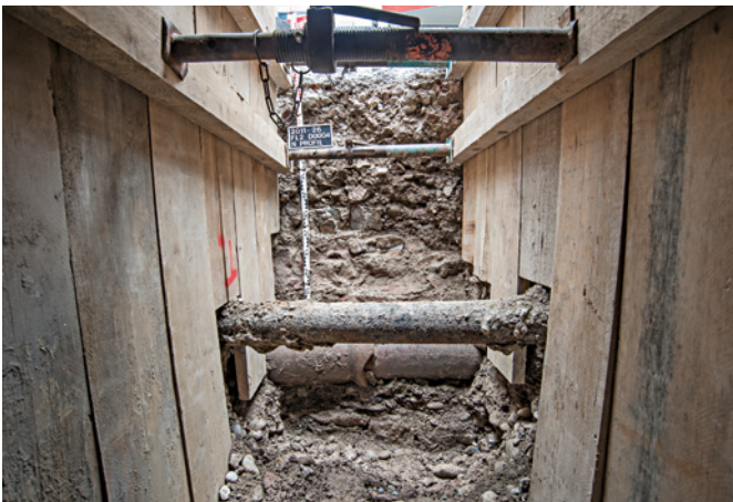
Abb. 43 Blick in den Leitungsgraben und auf die Kontermauer. Foto: Christian Stegmüller.
