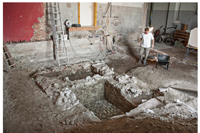
Abb. 44 Die beiden Senkgruben im südlichen Hausteil. Foto: Christian Stegmüller.
