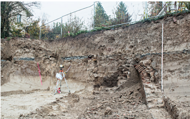
Abb. 74 Blick auf die Baugrube mit dem Rest des Gewölbes aus dem 19. Jahrhundert. Foto: Christoph Matt.
