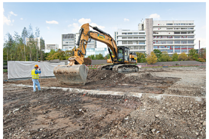
Abb. 67 Voraushub mit grossem Gerät: der Baggerfahrer legt die intakte Fläche unter Anleitung eines erfahrenen Ausgräbers vorsichtig frei. Foto: Denise Grossenbacher.
