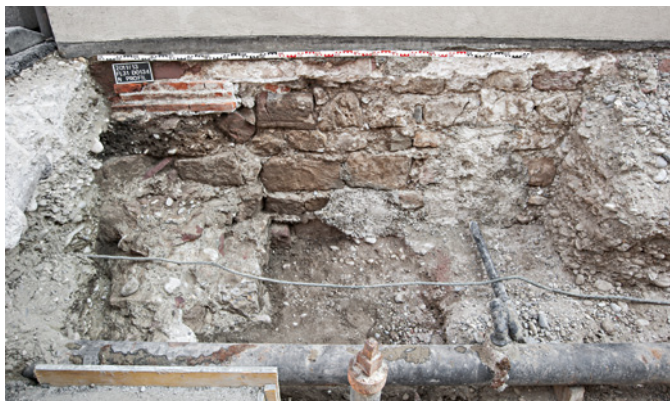
Abb. 37 Der aus Quadern gebildete kräftige Vorbau des Torturms liegt auf der Flucht des Petersgrabens (links) und führt unter der Hausfassade nach rechts (Osten) zum Schwibbogen. Foto: Christian Stegmüller.
