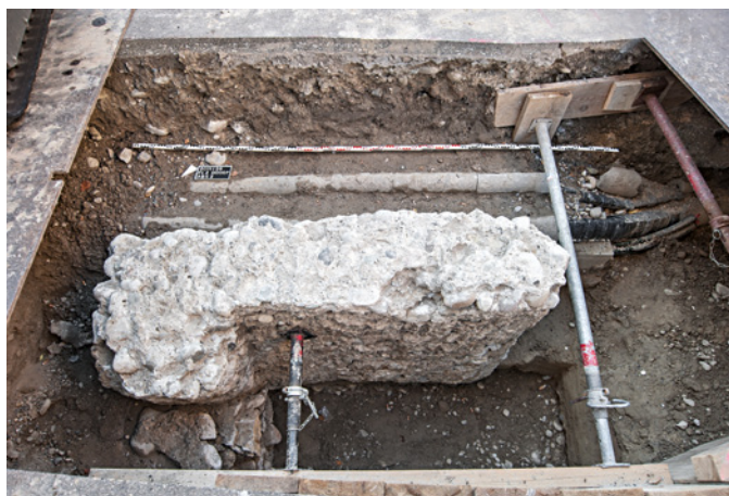
Abb. 47 Blick auf den Fundamentwinkel an der Riehentorstrasse. Gegen vorne links baut der Winkel an ein älteres Fundament an (unten), gegen rechts endet er als klare Mauerzunge. Foto: Christian Stegmüller.
