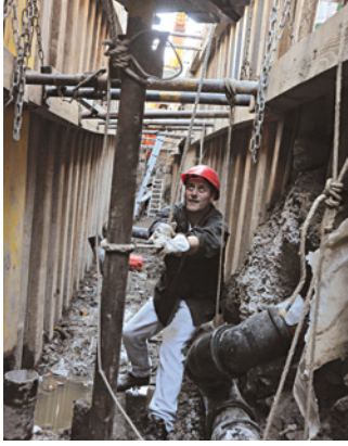
Schwerarbeit: Die Gefrierlanze für die Sondierbohrung wird mit Unterstützung des Ausgräbers Roman Rosenberger und des Baggers in den Boden gerammt. Foto: Jan Baur.
