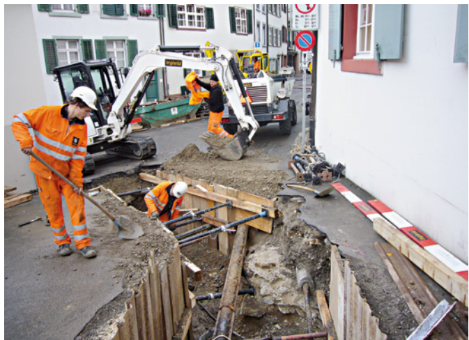
Abb. 30 Der Mauerstumpf vor dem Haus Heuberg 26 / Leonhardsgraben 43 nach der Freilegung. Foto: Christoph Matt.
