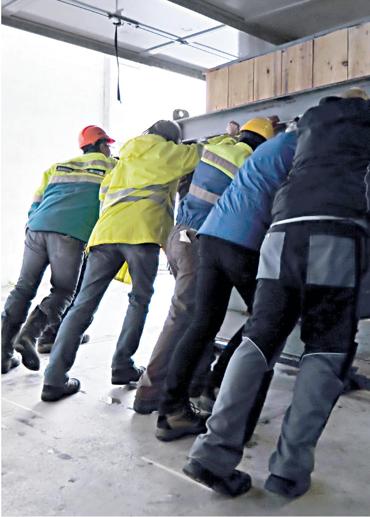
**Abb. 12** Manpower pur: Auf Schwerlastrollen wird der Block an seinen Platz geschoben. Damit der Geschosboden standhält, wurde der darunterliegende Luftschutzkeller mit Baumstämmen ausgespriesst. Foto: Denise Grossenbacher.
