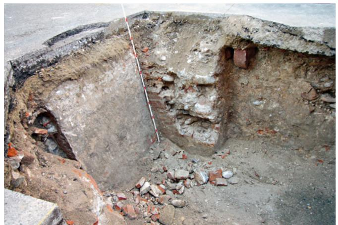
**Abb. 56** Zu Beginn der Tiefbauarbeiten wurde an der Ecke Spalenberg/Schnabelgasse der Keller des um 1900 abgerissenen Hauses «Zum Hauenstein» (ehemals Schnabelgasse 1) freigelegt. An der Wand hinten ragt noch ein Konsolstein der Balkendecke heraus. Foto: Christoph Matt.
