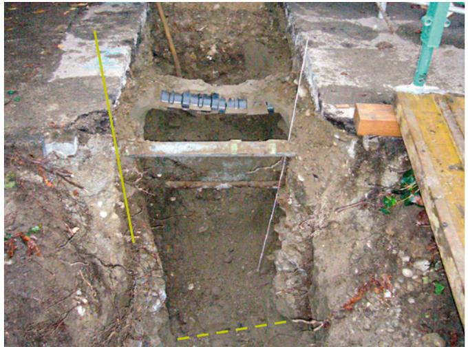
**Abb. 58** Blick nach Norden auf den Leitungsgraben mit dem leicht schräg in den Graben ziehenden (durchgehende Linie) und dem abgebrochenen (gestrichelte Linie) Mauerfundament. Foto: Christoph Matt.
