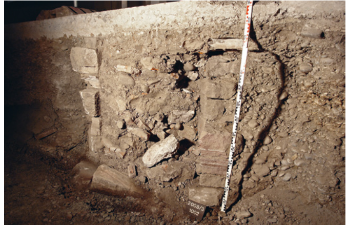
Abb. 9 Mit Abbruchschutt verfüllter kreisrunder Schacht. Foto: Sven Straumann.
