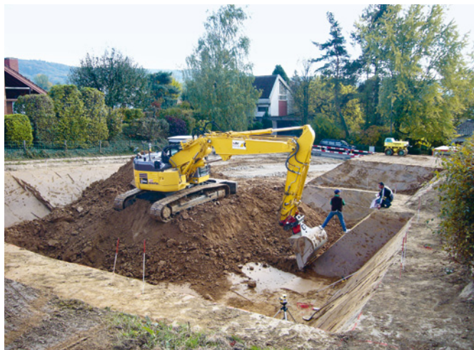
Abb. 51 Blick in die Baugrube. Foto: Christoph Matt.
