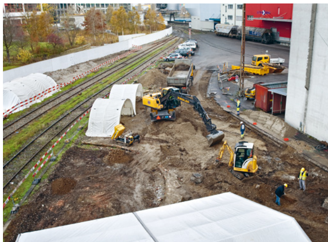
Abb. 47 Übersicht über die Grabungen im Rheinhafen St. Johann im November 2009 mit Blick nach Nordosten. Ganz links am Arealzaun zum Parkgelände des Novartis-Campus die Grabung 2009/22; in der Bildmitte der laufende Voraushub für die Grabungen 2009/27 und 2009/36; ganz rechts angeschnitten das Ultra-Brag-Silo. Foto: Michael Wenk.
