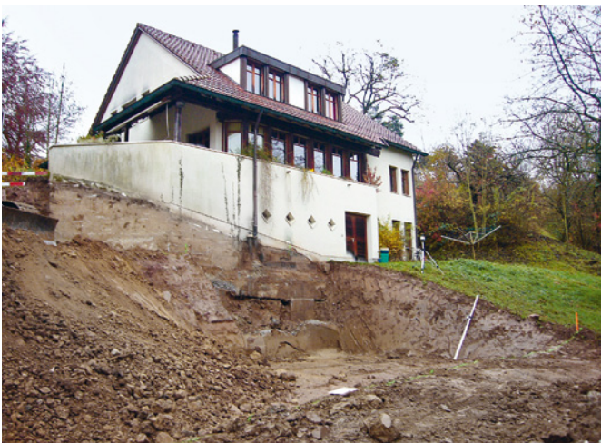
Abb. 52 Überblick über die Baustelle. Foto: Christoph Matt.
