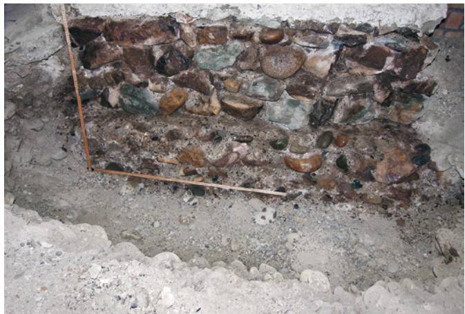
Abb. 32 Das freigelegte Fundament-Mauerwerk mit der unten breiteren Bauetappe im 1. Untergeschoss. Foto: Christoph Matt.
