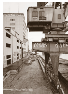
Abb. 4 Archäologie im Rheinhafen St. Johann unmittelbar vor dem Abriss der Anlagen.
