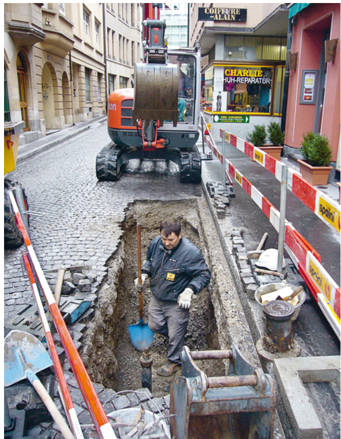
Abb. 30 Blick über die Baustelle. Foto: Christoph Matt.
