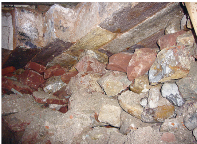
Abb. 44 Blick auf den Abbruchschutt unter dem Gewölbe. Foto: Christoph Matt.
