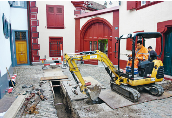
Abb. 16 Rittergasse (A) 11–19A, 2009/8. Das Baugeschäft öffnet die Gräben für die neue Gasleitung in der Rittergasse. Foto: Christian Stegmüller.
