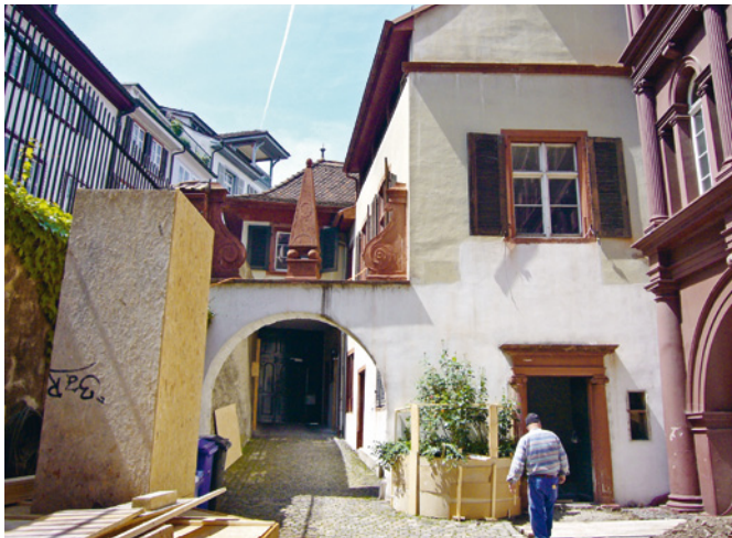
Abb. 35 Blick auf die Zufahrt zum Heuberg mit dem Torbogen und dem westlichen Seitenflügel mit dem Renaissanceportal. Rechts schliesst der Renaissanceflügel an. Foto: Christoph Matt.
