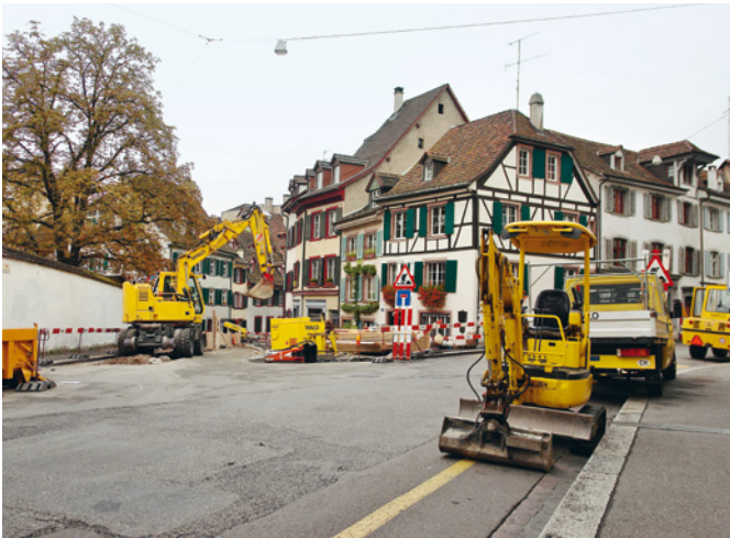
Abb. 39 Blick auf die Leitungsraben-Baustelle. Foto: Christian Stegmüller.
