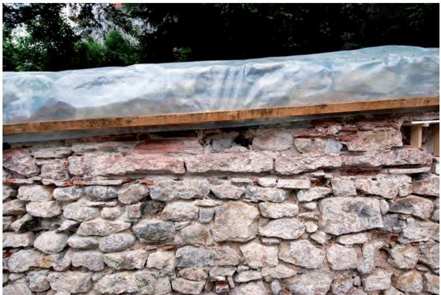
**Abb. 6** Mühlenberg 12 / St. Alban-Vorstadt 65, 69, 71. Ausschnitt von Teil 3 der Mauer. Die nachträgliche Aufstockung ist gut zu erkennen. Darunter liegt ein durchgehendes Band aus ca. 10 cm dicken Buntsandsteinplatten, welche als ehemalige Abdeckung der Mauer dienten. – Foto: Bernard Jaggi.
