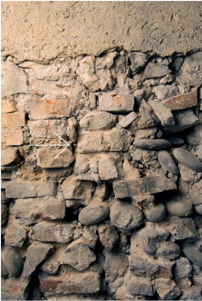
**Abb. 6** Lindenberg 17/19. Nördliche Hofmauer. In einer neuzeitlichen Reparaturzone im rechten oberen Mauerbereich (Bauphase 4, d, siehe Abb. 3) sind einige Kalkmörtelformsteine oder Bruchstücke davon eingemauert (weisser Pfeil). Sie bestehen aus feinsandigem Mörtel und haben die Grösse von Backsteinen. – Foto: Matthias Merki.
