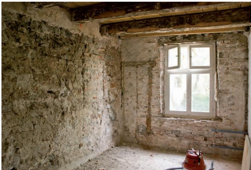
**Abb. 8** Unterer Heuberg 7. Haus West, EG, nordwestlicher Raum (Gartenseite). Die freigelegten Mauern zeigen links mittelalterliches Mauerwerk in der Brandmauer mit Brandschäden (13. Jh.). Im Hintergrund eine eingebrochene, später zugemauerte Nische. Darüber die sekundär eingelassenen Deckenbalken von 1384. Hinten die Gartenfassade mit einer nachträglich vermauerten Türöffnung (Holzsturz und Leibungskante). – Foto: Bernard Jaggi, 2008.
