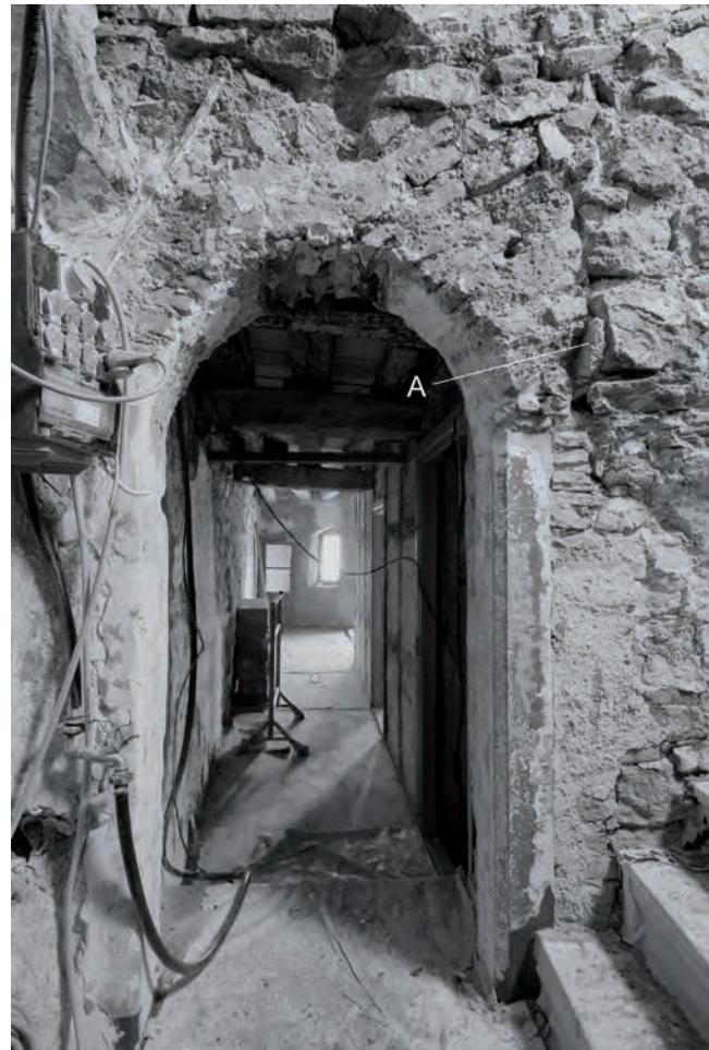
förmigen Spickel sind mit kleinteiligen Backsteinfragmenten gestopft. Die nördliche Leibung besteht aus Backsteinen und Kalkbruchsteinen und ist an einzelnen Stellen in den Mauerwinkel eingeflickt. Das südliche Sandsteingewände ist ein Ersatz aus dem 19. Jahrhundert.
