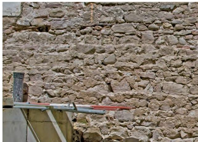
**Abb. 17** Klosterberg 9. Westliche Hofmauer. Der untere Bereich der neuzeitlichen Mauer (18. Jahrhundert) stand ursprünglich im Boden. Gut erhalten sind die Abdrücke horizontaler Schalungsbretter. – Foto: Philipp Ryffel.
