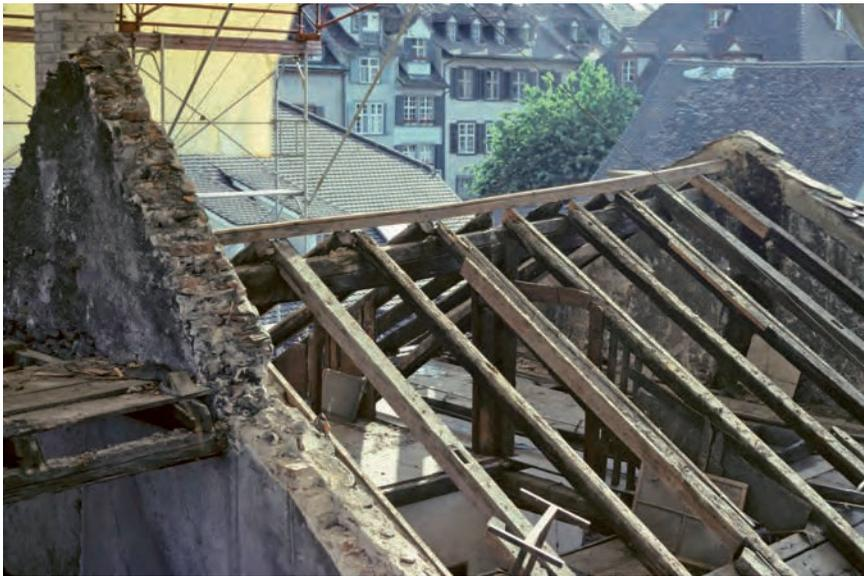
**Abb. 13** Unterer Heuberg 7. Abgedecktes Dachwerk von Haus West. Auf der zwischen die Giebelmauern gespannten Firstpfette liegen die Rafen nebeneinander, mit Holznagel fixiert. Der Firstpfosten in der Mitte ist Teil eines mittleren Binders. Im Vordergrund der höhere Giebel von Haus Ost. Das Dachwerk wurde 1979 unter Belassung des mittleren Binders abgebrochen. – Foto: Bernard Jaggi, 1978, Archiv DPFBS.
