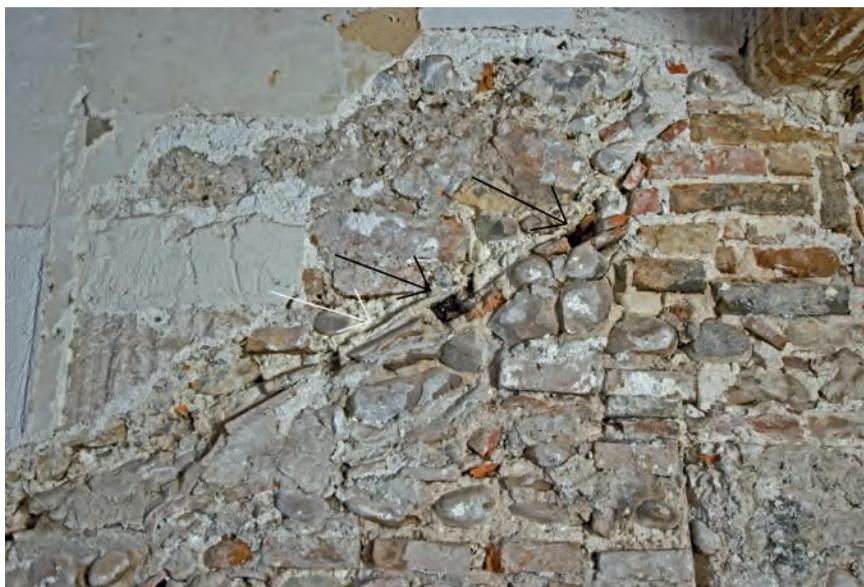
**Abb. 15** Klosterberg 9. Erstes DG, Westbrandmauer. Aufmauerung der 3. Bauphase von Klosterberg 9 mit erhaltener Dachlinie. Die schwarzen Pfeile weisen auf zwei verkohlte Reste originaler Dachlatten. Der weisse Pfeil zeigt auf den Abdruck eines Hohlziegels in feinsandigem Abstrichmörtel. – Foto: Matthias Merki.
