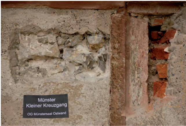
**Abb. 3** Münster, Münstersaal-Ostfassade. Wandsondierung am südlichen Gewändepfosten der zugemauerten Öffnung (siehe Abb. 1), die zum Originalbestand der Fassade gehört. Auf der Gewändekehle sind auf weisser Tünche grüne Farbreste erhalten. Der Ladenfalz beschneidet nicht nur die Kehle, sondern auch die Farbschicht. Damit erweist er sich als sekundär. – Foto: Matthias Merki.
