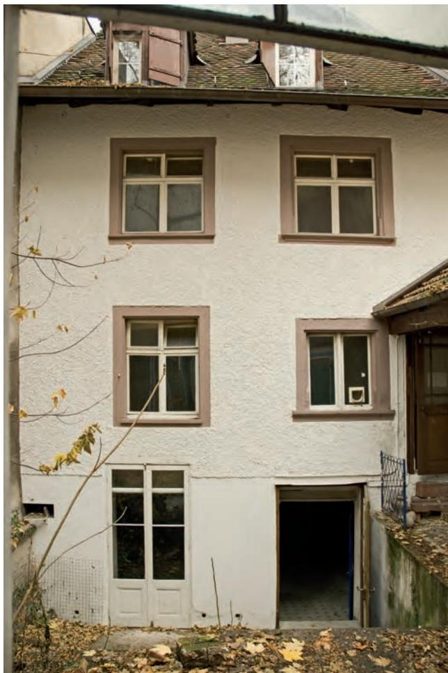
**Abb. 5** Klosterberg 9. Hoffassade. Im Vordergrund der hoch liegende Teil des hinteren Hofes und rechts aussen dessen Erschliessung über die Laube durch die eingezwängte Türe im 1. OG. In der rechten Fensterachse sind die wieder verwendeten gotischen Gewände zu sehen, wobei das obere Gesims mit Wulst und abgesetzter Kehle barock ausgeformt ist. Die Türe im EG links ist eine moderne Erweiterung einer ehemaligen Fensteröffnung. – Foto: Matthias Merki.
