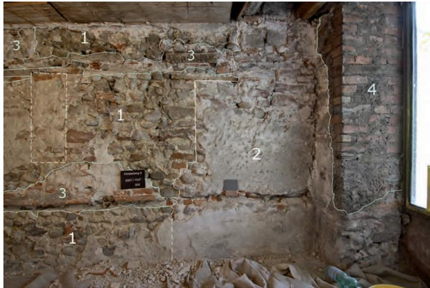
Einige Dezimeter nördlich der Firstachse endet die mittelalterliche Mauerstruktur im Erdgeschoss mit einer vertikalen Abbruchkante. Sondierungen an der daran hofseitig anschliessenden Mauer zeigten ein neuzeitliches Mauerbild. Dieser Aufschluss war auf das Erdgeschoss beschränkt, in den oberen Geschossen bleibt mangels Freilegungen die Frage der horizontalen Ausdehnung offen.
