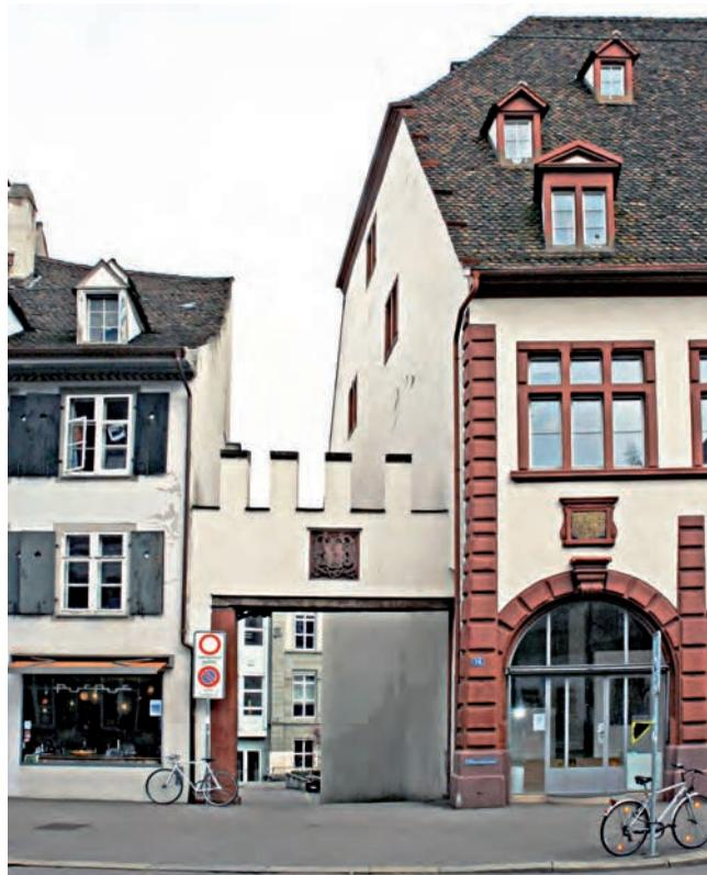
Im Sommer 2008 kollidierte der Ausleger einer Baumaschine bei der Fahrt durch das Tor zwischen den Häusern Spalenvorstadt 14 und 16 mit einem Sturzbalken, so dass dieser in der Mitte angerissen und nach aussen gedrückt wurde. Der Verputz zwischen Balken und Wappenrelief platzte ab und legte das Mauerwerk frei. Um der Einsturzgefahr vorzubeugen, wurde der beschädigte Balken von den Zinnen her mit Gurten gesichert. Es stellte sich heraus, dass sein Zustand schon zuvor sehr schlecht gewesen war.
