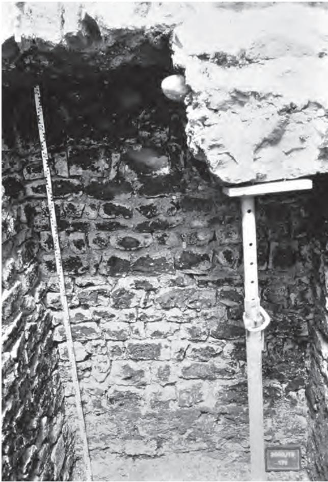
**Abb. 2** Schnabelgasse 6. Die nördliche Latrinemauer aus regelmässig geschichteten Kalkbruchsteinen, die mit einem grobkörnigen Mörtel vermauert wurden. Der Mörtel ist vom sauren Latrineneinhalt stark angegriffen. – Foto: Catrin Glaser.
