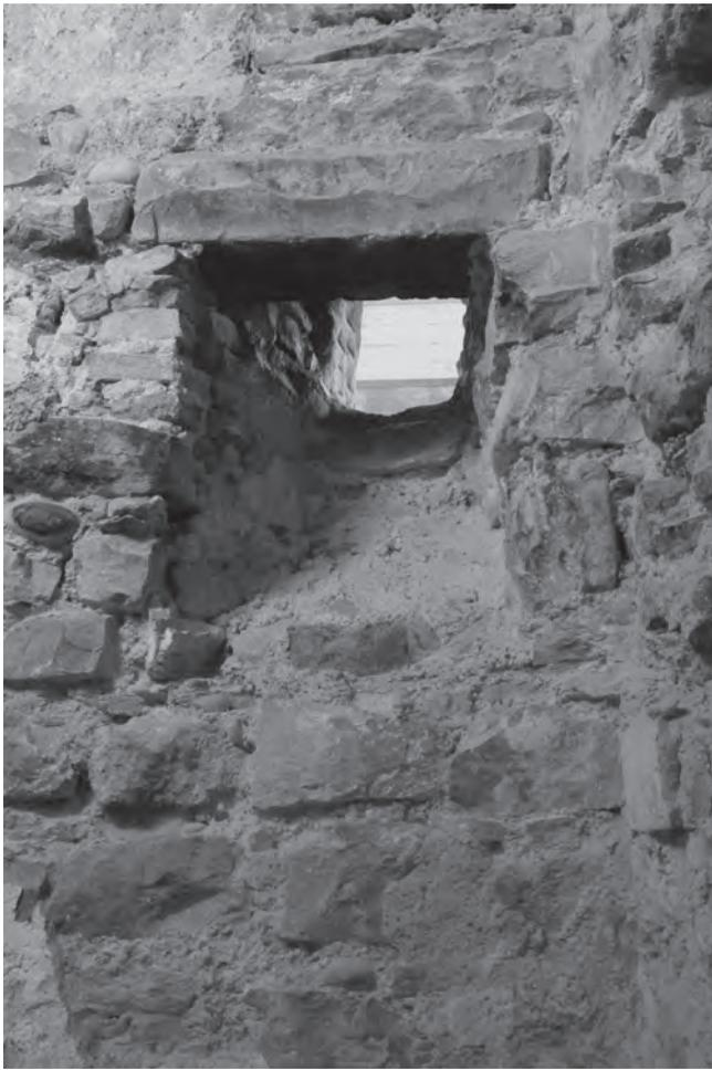
**Abb. 19** Blumenrain 28. Ursprünglich angelegte Rauchabzugsöffnung am Baukörper von 1335 (Freilegung an der Innenseite der rheinseitigen Aussenmauer im 2./3. UG). Die aussen schlitzartige Öffnung wird innen breiter und zieht sich schräg nach unten (siehe Kapitel 3.3). – Foto: Daniel Huber.
