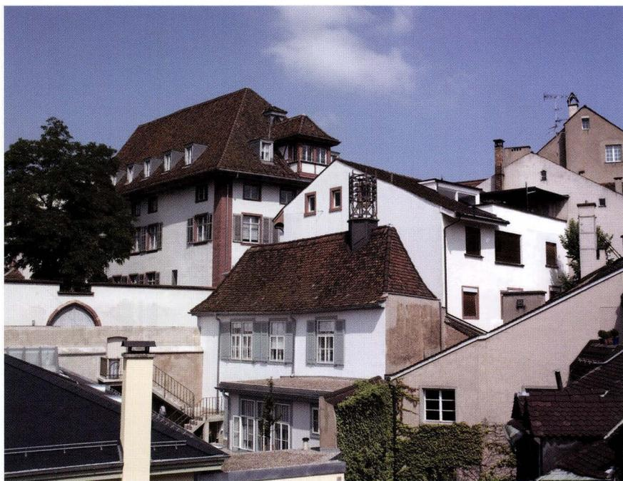
**Abb. 3** Nadelberg 11A. Blick von der Talseite zum «Uhrenhäuschen». Im Hintergrund der Engelhof. Auf dem Dachfirst sitzt der Isolatorenturm als Dachreiter. Über der schräg zur Längsfassade verlaufenden Schmalseite des Häuschens liegt die steinerne Dachrinne. – Foto: Basler Denkmalpflege.
