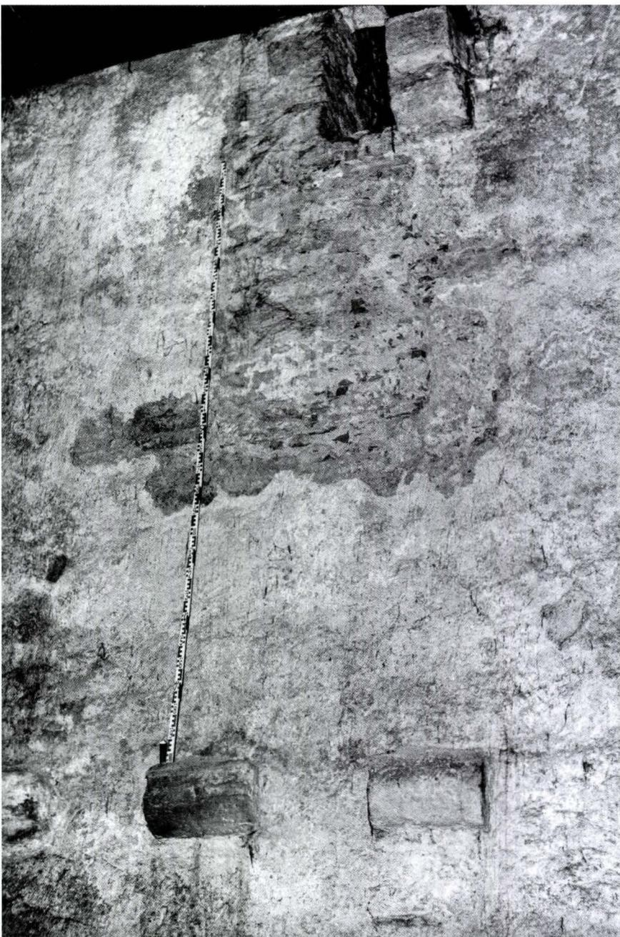
**Abb. 40** Nadelberg 6 – Schönes Haus. Zugemauertes Kellerfenster in der Westmauer des Hauptkellers. Die Zumauerung von 1864 schied oben neben dem mittelalterlichen Konsolstein eine kleine Lüftungsöffnung aus, die beim Umbau von 1966/70 aufgegeben wurde. – Foto: Basler Denkmalpflege, 1966.
