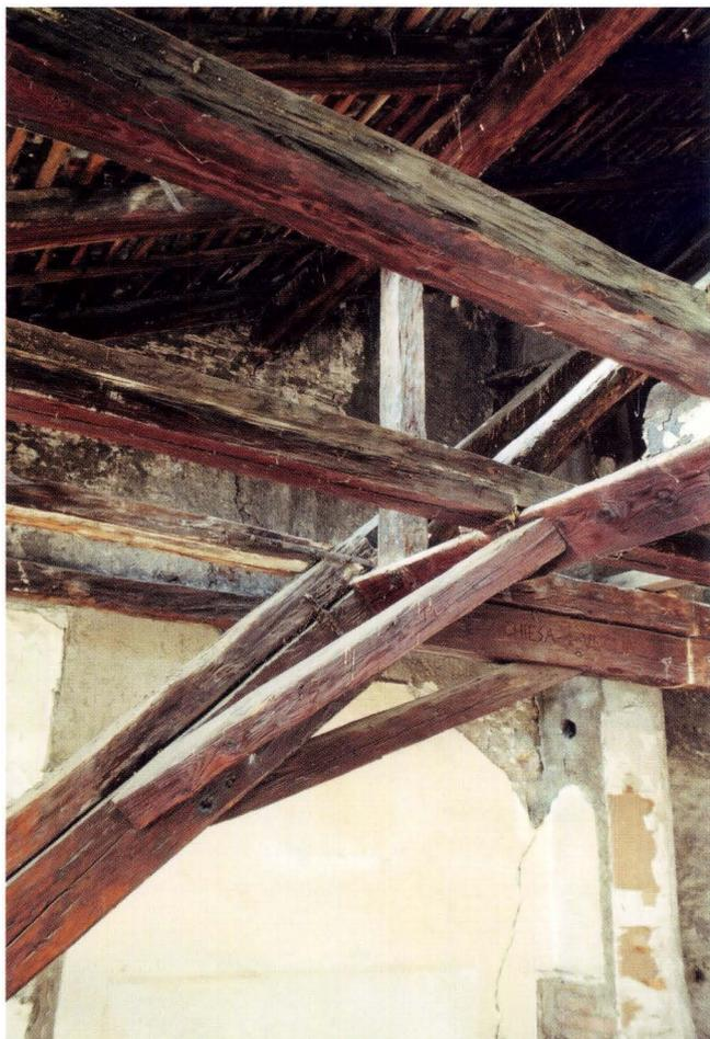
cke Mauerwerk umfasst im Bereich des Geschossbodens einen Balken, welcher wie die andern Bodenbalken des zweiten Obergeschosses die Gebäudebreite des ungeteilten Hauses überspannt. Dieser und ein benachbarter Balken sind dendrochronologisch ins Jahr 1670/71 datiert.
