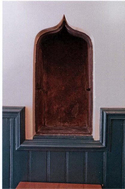
**Abb. 5** Rheingasse 15. Erdgeschoss, strassenseitiger Raum (Gaststube). Gotische Nische mit Kielbogen in der Nordbrandmauer (gegen Nr. 13). Sandstein. Etwas unterhalb der Mitte sind in den Leibungen Nuten eingelassen für ein Holztablar. – Foto: Basler Denkmalpflege, Benjamin Fischer.
