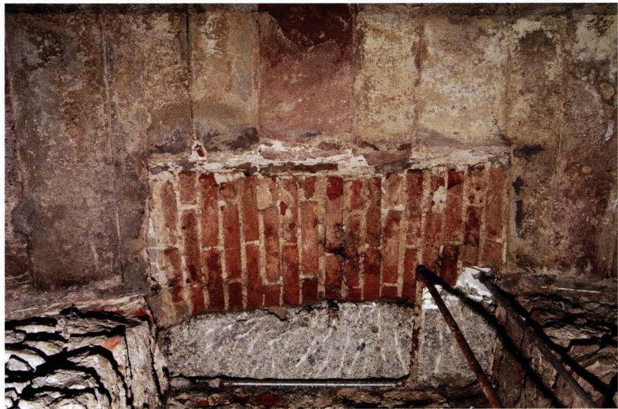
In der Mitte der Ostmauer ist ein Unterzug (6) in Eichenholz unterhalb der Deckenbalken eingelassen. Er liegt nur minimal im Mauerwerk (1) und ist von einem zementhaltigen Mörtel umgeben.<sup>43</sup> Sein Fälldatum ist 1635, während die ebenfalls alle in Eiche gefertigten Deckenbalken dendrochronologisch in die 1270er-Jahre, d. h. in die primäre Bauzeit datieren.<sup>44</sup>
