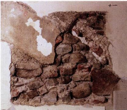
**Abb. 16** Rheingasse 15. Nordbrandmauer. Mischmauerwerk unterhalb der alten Dachschräge (Abb. 15, Pos. 1), darüber im hellen Mörtel die Reparatur (Pos. 2) und zuoberst die Erhöhung (Pos. 3). – Foto: Basler Denkmalpflege, Urs Bachmann.
