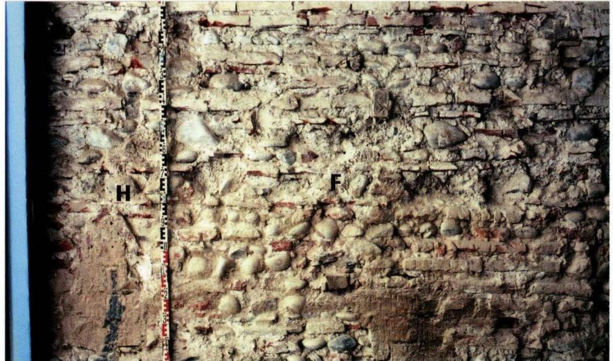
**Abb. 14** Gerbergasse 59. Nordbrandmauer im EG, Abschnitt in der Parzellenmitte. In der aus dem 15. Jahrhundert stammenden Mauer (F) ist der in drei Phasen zugemauerte Wandkasten (I) eingebaut. – Foto: Basler Denkmalpflege
