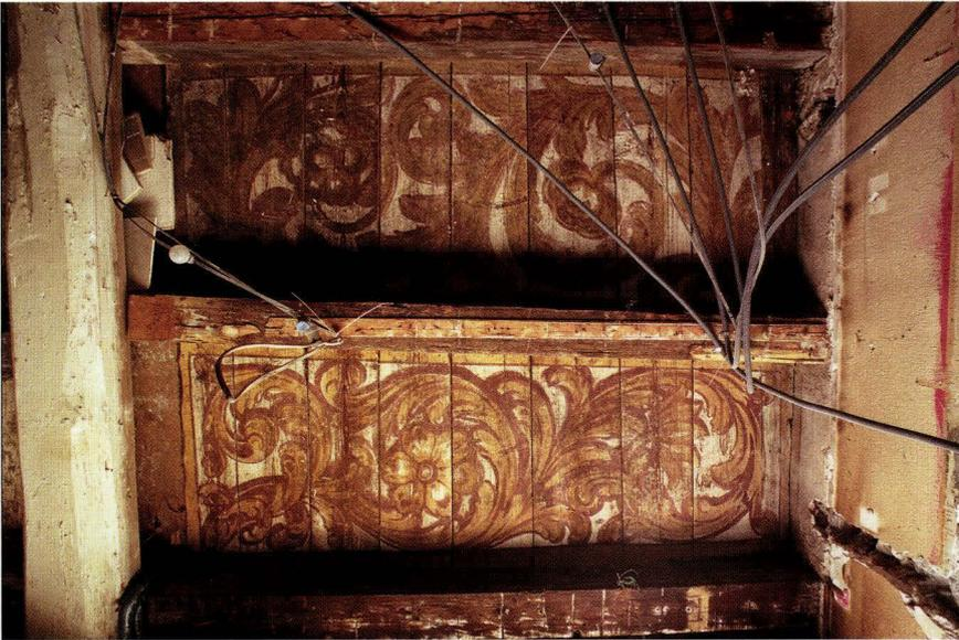
**Abb. 14** Webergasse 29. Bemalte Balkendecke im vordersten Abschnitt des Erdgeschosses. Die Malerei zeigt ein zweifarbiges Rankenmotiv. Die Stelle der im 18. Jahrhundert entfernten Binnenwand ist an den dort fehlenden Malschichten sichtbar geblieben (links). – Foto: Basler Denkmalpflege.
