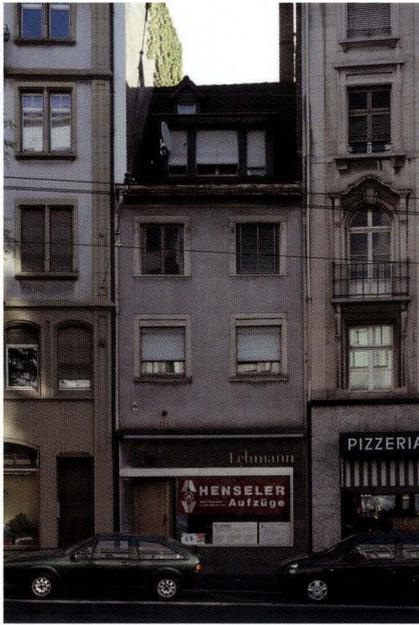
**Abb. 2** Blumenrain 14. Strassenseitige Fassade des Gebäudes. Das beidseits an Bauten aus der Zeit der vorletzten Jahrhundertwende grenzende Altstadt- haus ist im strassenseitigen Erscheinungsbild stark von den Umbauten von 1960 (Schaufenster) und 1967 (Dachgaube) geprägt.
