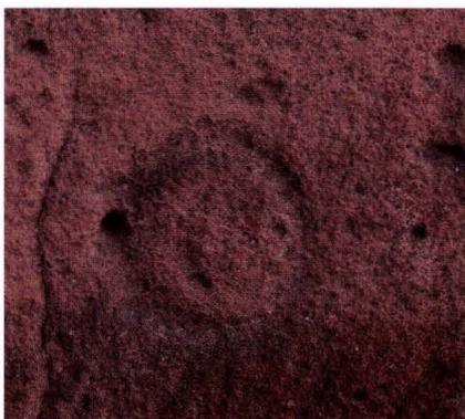
**Abb. 2** Münsterplatz 9. Erstes freistehendes Turmgeschoss, Südfassade: Das Zeichen befindet sich unmittelbar rechts der Schallöffnung (siehe Abb. 3) auf der fassadenbündigen Fläche des Werkstücks, welches Teil des rechten Fenstergewändes ist. Wiesentäler Sandstein. Die Bearbeitungsspuren mit der Glattfläche sind erstaunlich gut erhalten. – Foto: Basler Denkmalpflege, Basil Marty.
