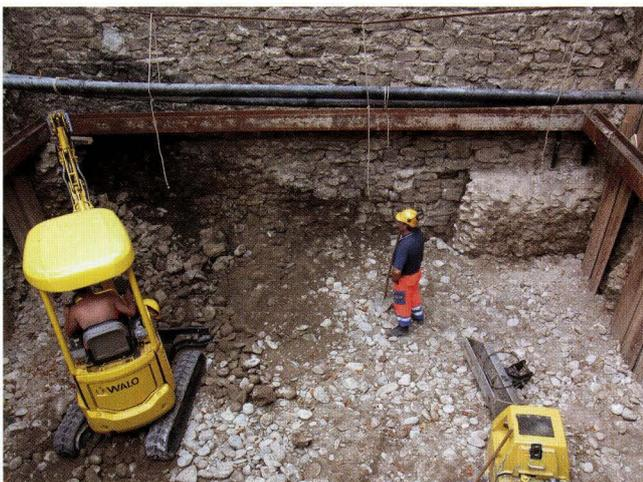
Die innere Grabenwall-Mauer wurde ohne Baugrube satt gegen das anliegende Erdmaterial gebaut (Abb. 17). Sie ist an der der eigentlichen Stadtmauer zugewandten Sichtseite mit Kalkbruchsteinen aufgemauert; auf der ans Erdreich gelehnten Feindseite besteht sie so gut wie ausschliesslich aus Kieselwacken. Dort quillt der Mauermörtel zwischen den Steinköpfen hervor. Die Breite des Fundaments liegt bei 0,6 m. An einer Stelle wurde eine mit Backsteinen vermauerte Ausflückung beobachtet.
