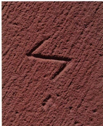
**Abb. 6** Münsterplatz 9. Erstes freistehendes Turmgeschoss, Ostfassade. Das einfache Zeichen ist sorgfältig auf einem Werkstück des linken Fenstergewändes eingraviert. Trotz der deutlich abgewitterten Oberfläche des Wiesentäler Sandsteines ist oben der Randschlag des Werkstücks noch erkennbar. – Foto: Basler Denkmalpflege, Basil Marty.
