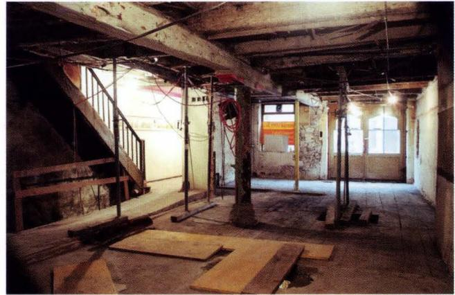
**Abb. 8** Webergasse 29. Die Deckenbalken des Erdgeschosses überspannen nur je die halbe Breite des Gebäudes und sind in der Mitte auf einem parallel zu den Brandmauern liegenden Unterzug aufgelegt. – Foto: Basler Denkmalpflege.
