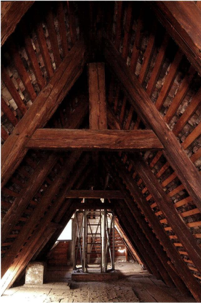
**Abb. 10** Nadelberg 11A. Dachraum des «Uhrenhäuschen» in Blickrichtung Talseite. Das einfach stehende Sparrendach von 1488 (d) hatte ursprünglich drei Firstständer, die durch die kurzen, auf Hahnenbalken gestellten Firststiele ersetzt wurden. Im Hintergrund steht das Eisengerüst des Isolatorenturms, von dem aus die Leitungen von der Mutteruhr zu den städtischen Uhren gespannt waren. Dahinter der zum ursprünglichen Dachwerk gehörende Walm. – Foto: Basler Denkmalpflege.
