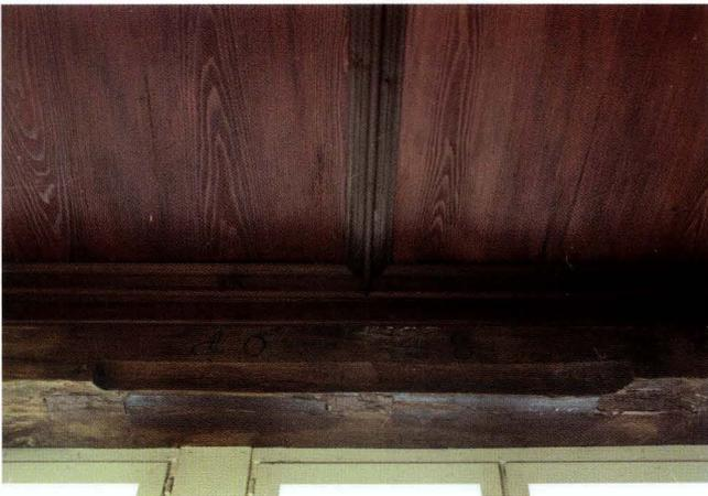
**Abb. 10** Webergasse 29, 2. Obergeschoss. Sturzholz im vorderen Zimmer des östlichen Hausteils. Die innere Kante ist über die Breite eines einteiligen Fensters gefast. An der Unterseite des Sturzes sind Zapfenlöcher für Seiten- und Mittelpfosten dieses Fensters sichtbar. Inscriptliche Datierung 1648 (dd 1647/48). – Foto: Basler Denkmalpflege.
