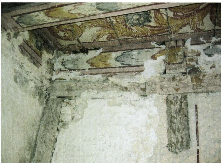
**Abb. 50** St. Alban-Vorstadt 14 (2003/152). Nebenraum auf der Gartenseite im 2. OG. Die Fachwerkwand trennt den grossen Täfelraum dahinter ab. Der obere Rähmbalken schliesst nicht an die Deckenbretter an, um rückseitig als Anschlussbalken der Täfeldecke zu dienen. Die barocke Rankenmalerei füllt den oberen Streifen zwischen Wand und Decke in der Art einer Balkenbemalung. Die Dekoration stammt aus dem Umbau Ende des 17. Jahrhunderts. – Foto: Basler Denkmalpflege.
