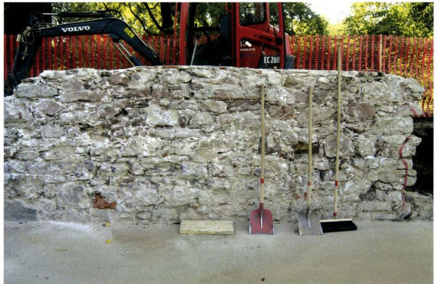
**Abb. 7** Sarasinpark, Baselstrasse / Inzlingerstrasse, Riehen (2003/468). Mauerteil anschliessend an die moderne Eckausbildung. Die Mauer an der Baselstrasse ist mit Pfeilervorlagen regelmässig gegliedert. – Foto: Basler Denkmalpflege.
