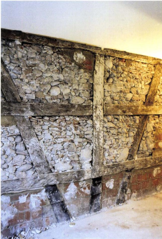
**Abb. 60** Unterer Heuberg 7 (2003/384). Ausschnitt aus der Fachwerkbrandwand im hinteren Teil des 1. OG. Die Wand zeigt die gleiche Ordnung wie im EG. Sämtliche Hölzer sind aus Eiche. Die Gefache sind grösstenteils noch original. – Foto: Basler Denkmalpflege.
