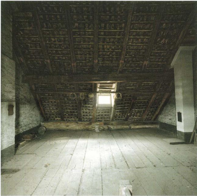
**Abb. 37** St. Alban-Vorstadt 9 (2003/172). Innenseite der Dachfläche gegen den Garten. Das Dachwerk setzt sich aus einem Pfetten-tragwerk, das zwischen die Brandmauern gespannt ist, und darauf aufliegenden Rafen zusammen. Das Dachwerks könnte zusammen mit der gartenseitigen Fassadenbemalung Ende 15. Jahrhundert entstanden sein. – Foto: Basler Denkmalpflege (Bruno Thüring).
