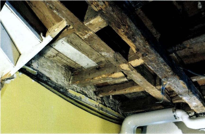
**Abb. 56** St. Johannis-Vorstadt 32, zum kleinen Johanniter (2003/250). 2. Untergeschoss, Decke gegen die Nord-Brandmauer. Der parallel zur Mauer liegende Wechsel zeigt, dass die Treppe vormals entlang der Wand ins 1. Untergeschoss hinauf führte. – Foto: Basler Denkmalpflege.
