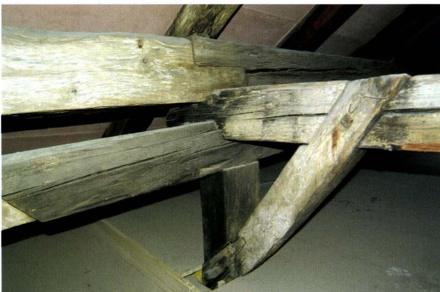
**Abb. 33** Rittergasse 19A (2003/136). Knotenpunkt des Mittelständers des Pultdachstuhls. Die unteren Hölzer zeigen die originale Ausführung mit Ständer, Pfette und aufliegendem Kehlbalken. Dieser ist über ein angeblattetes Kopfband mit dem Ständerholz verstrebt. Die parallel aufliegende Pfette gehört zur Dachanhebung. – Foto: Basler Denkmalpflege.
