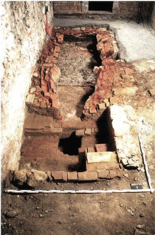
Die Fundamente der Parzellenmauern reichen bis in den anstehenden Kies. Die Fassade der Liegenschaft Steinentorstrasse 5 ist weniger tief fundamementiert. Ihr Fundament setzt etwa auf Höhe des frei aufgehenden Mauerwerks der Seitenwände an. Das moderne Strassenniveau der Steinentorstrasse liegt nur wenig höher – ein Hinweis, dass das Gelände-Niveau in diesem Teil der Steinenvorstadt seit dem Mittelalter kaum verändert worden ist.
