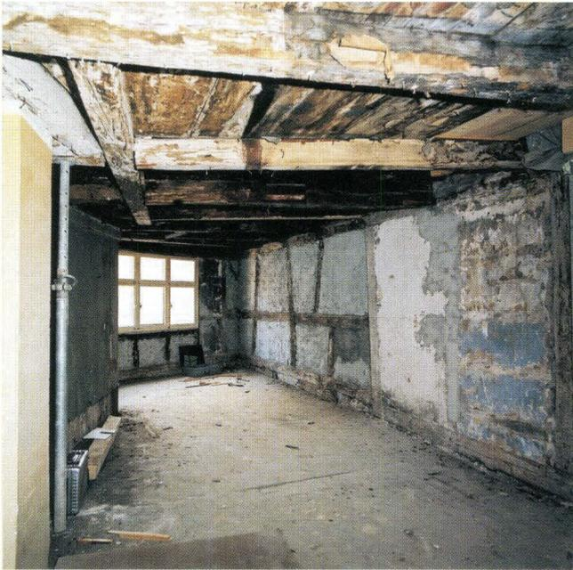
**Abb. 5** Barfüsserplatz 23 (D 2001/12). Drittes Obergeschoss mit Blick gegen Osten. Links die Holztrennwand zur Gerbergasse 83. Rechts Flickstelle in der Fachwerkwand gegen Süden, am Ehgraben. – Foto: Basler Denkmalpflege.
