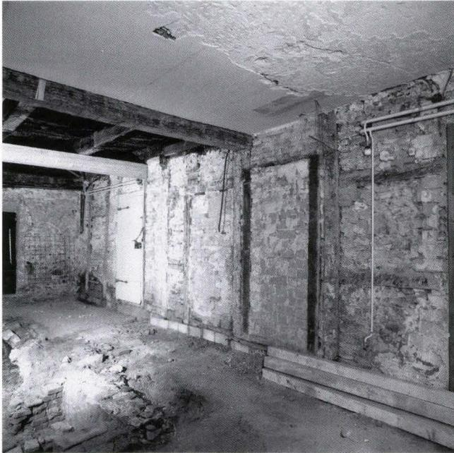
**Abb. 24** Klosterberg 21 (D 2001/2). Blick in den Ladenraum. Rechts die in Fachwerk gebaute Trennwand zum Gang. Im Hintergrund die Quermauer mit dem zugemauerten Spitzbogen. – Foto: Basler Denkmalpflege.
