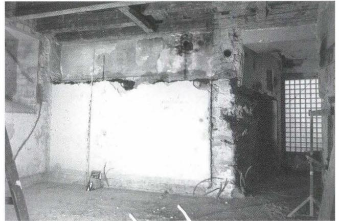
**Abb. 30** Lohnhof. Das Erdgeschoss des Eckturms, Blick zur Nordmauer. In der Decke das Treppenloch (rechts vom Wechselbalken). – Foto: Basler Denkmalpflege.
