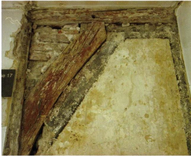
**Abb. 26** Hofflügel an der Nordbrandmauer: Detail im 2. OG. Ständer mit geschwungenem Kopfbug. Die Gefachfüllung mit der Graubandmalerei entstand erst nachträglich, der Flügelbau bestand ursprünglich als offene Laube und gehört wohl zur Umbauphase von 1550, die Ausfachung gehört ins späte 17. Jh. – Foto: Basler Denkmalpflege.
