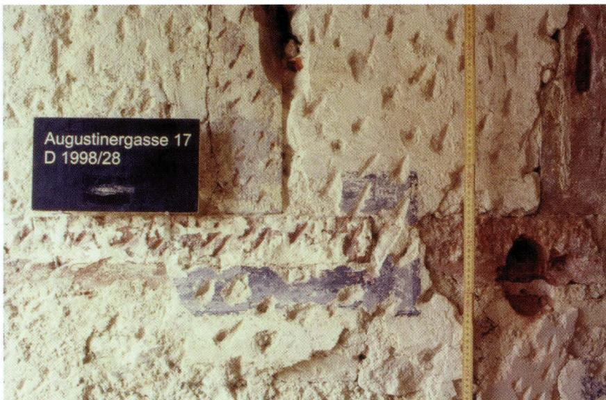
**Abb. 20** Vorderhaus, Hoffassade 2. OG, rechte Hälfte: Reste des Gurtgesimes unter orig. (vermauertem) Fenster. Das in einem ersten Schritt von rechts verkürzte Gesims wurde mit grauem Begleitband umfasst. Darauf stehen die Fensterstöcke mit dem schaufelartigen Kehlauslauf. – Foto: Basler Denkmalpflege.
