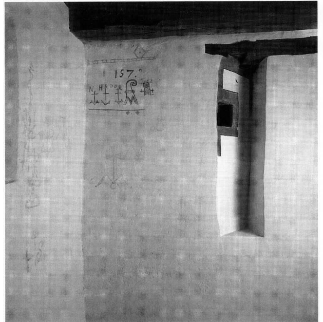
Abb. 6. Feld mit den „Wasserzeichen“ in der Nordwestecke des ehemaligen Arbeitsraumes im Parterre, renovierter Zustand. – Foto: BaDpfl.
