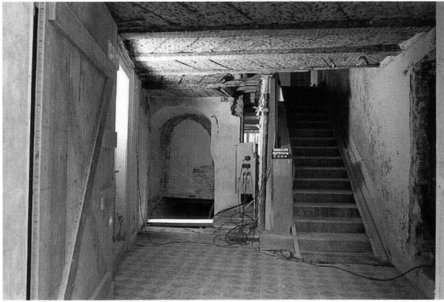
Abb. 10. Vorraum des Hauses im Parterre mit Blick auf die ursprüngliche Front des Kernbaus. Im Vordergrund Schiebbodendecke von 1478, beim Mauerpfeiler Ansätze eines Grisailledekors aus dem 16. Jh. – Foto: BaDpfl.
