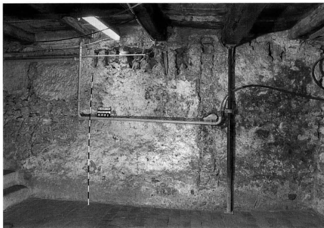
Abb. 7. Ostwand des Kellers mit den Pfählen im Mauerwerk. – Foto: BaDpfl.
