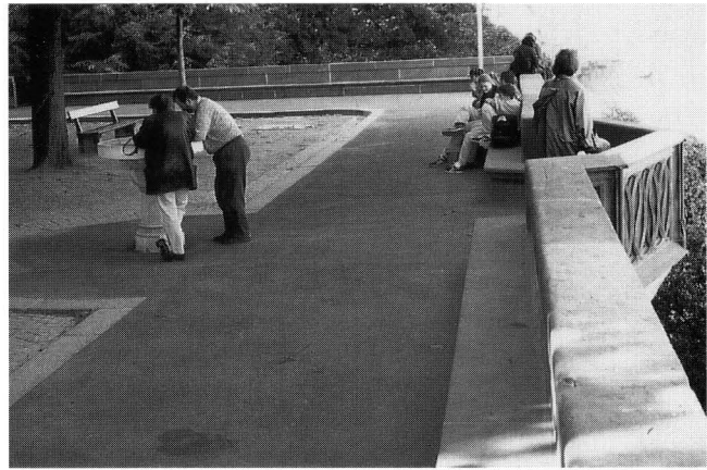
Abb. 9. Blick auf die Pfalzterrace mit der Kanzel (und dem sanierten Asphalt-Belag). – Foto: BaDpfl.
