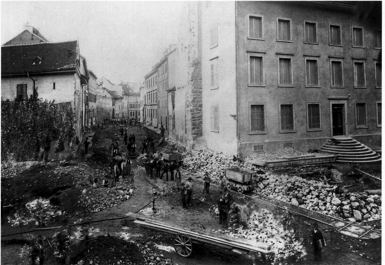
Abb. 9. Die Korrektur und Tieferlegung der äusseren Rittergasse nach dem Abbruch des St. Alban-Schwibbogens im Juli 1878 (Foto: A. Várady, StABS: Bildersammlung 2,115). – Foto: StABS.
