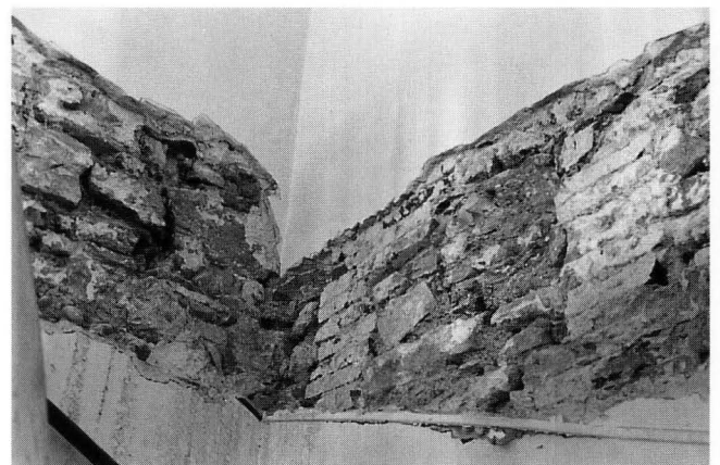
Abb. 2. Freigelegter Eckverband in der Südwestecke des Hauses (Treppenhaus) im 2. Stock. – Foto: BaDpfl.
