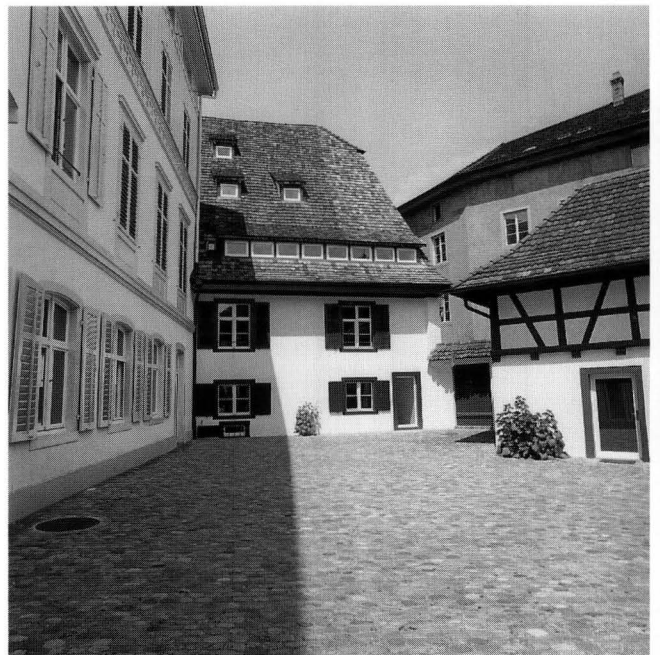
Abb. 2. Ansicht vom Hof, 1996. Links Thurneysen-Papierfabrik von 1847, rechts der barocke Stallbau an der Strasse. – Foto: BaDpfl.
