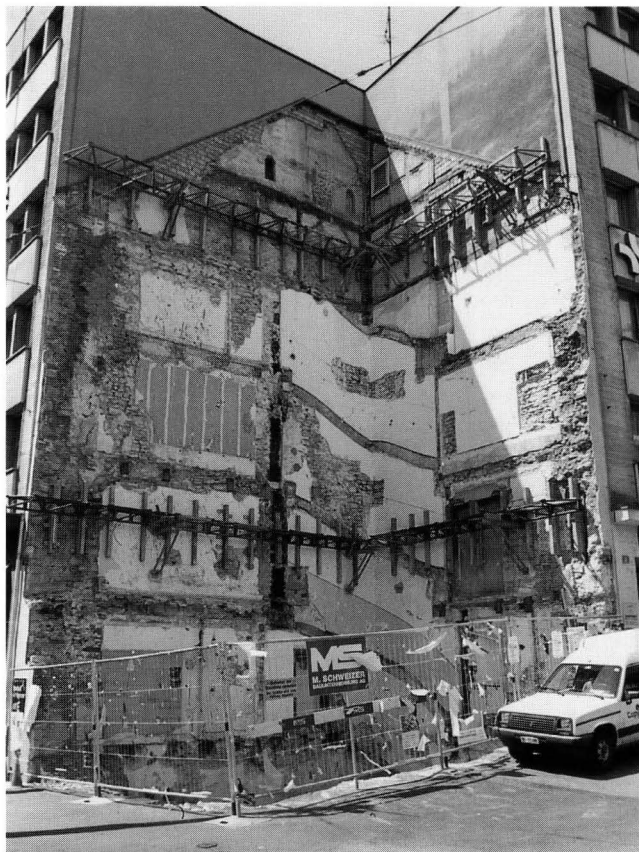
Abb. 7. Die Baustelle nach Abbruch des Hauses zum Bremgarten, Mai 1994. – Foto: BaDpfl.
