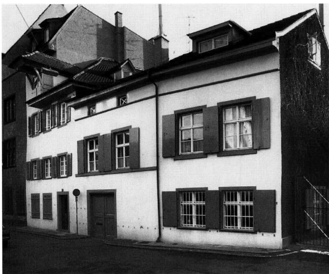
Abb. 1. Stiftsgasse 5. Am linken Bildrand der Engelhof (Stiftsgasse 1), rechts davon das Hauptgebäude und die beiden Flügelbauten von Haus Nr. 5. – Foto: P. Heman, Basel.
