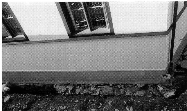
Abb. 2. Riehen – Baselstrasse 35, 1993/2. Blick auf die freigelegten Fundamente entlang des Chores. Baufuge zwischen dem gotischen Polygonalchor III und der letzten Chor- und Kirchenerweiterung IV von 1687–94. – Foto: U. Schön.
