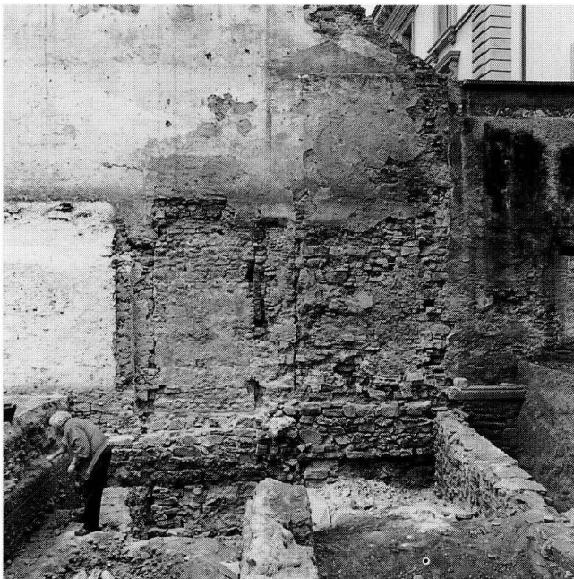
Abb. 3. Rittergasse 29/31. Die südliche Brandmauer nach Abbruch der Remise (Ausschnitt) mit dem ehemaligen Kellerportal (vgl. Abb. 2,5), Blick von Norden. – Foto: BaDpfl.
