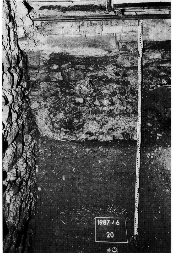
Abb. 7. Engelhof. Ansicht des Fundamentes der Hofmauer, Blick nach Osten. Die Hofmauer (Mauer MR 2) stösst an das Südfundament des Hauptbaus (links) an. – Foto: F 20.
