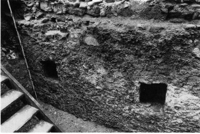
Abb. 4. Blick auf die nördliche Kellermauer (MR 3a) mit den beiden Nischen. Die Wand ist noch verputzt. Hinter bzw. über der Abbruchkante der Kellermauer ist Brandmauer MR 3b zu erkennen. – Foto: F 70.
