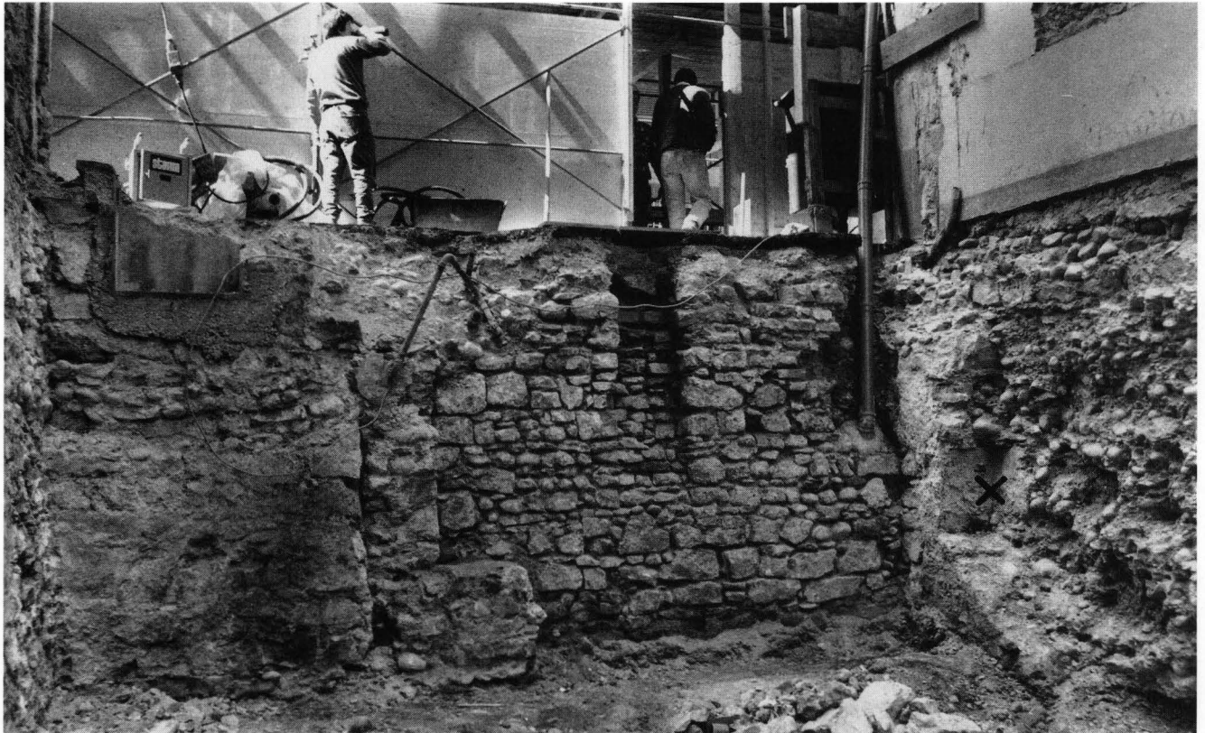
Abb. 3. Steinkeller aus dem 13. Jh., Blick auf die Westmauer (MR 7). In der Bildmitte (unter dem rechten Arbeiter) ist der Licht- oder Einfüllschacht in der Kellerwand zu erkennen, unter dem linken Arbeiter die ausgebrochene südliche Kellerwand (MR 9). Die nördliche Kellerwand mit den Lichtnischen (MR 3a) ist bereits grösstenteils abgebrochen; die westliche Nische aber noch erhalten (Kreuz). Dahinter und darüber ist die angebaute jüngere Mauer MR 3b sichtbar. – Foto: F 84.
