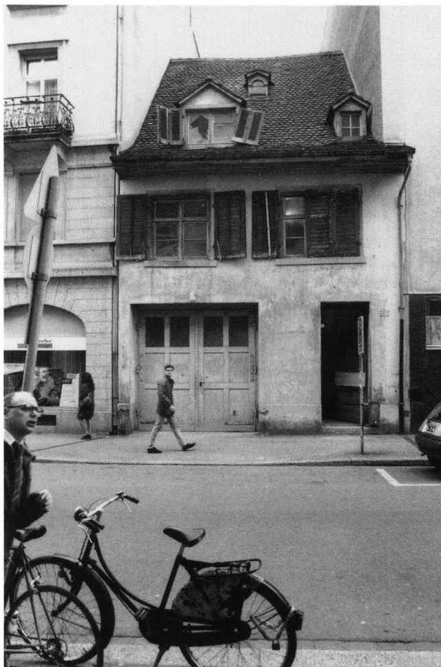
Abb. 1. Schützenmattstrasse 11, Gebäude vor dem Abbruch 1992 (Ansicht der Strassenseite). – Foto: BaDpfl.
