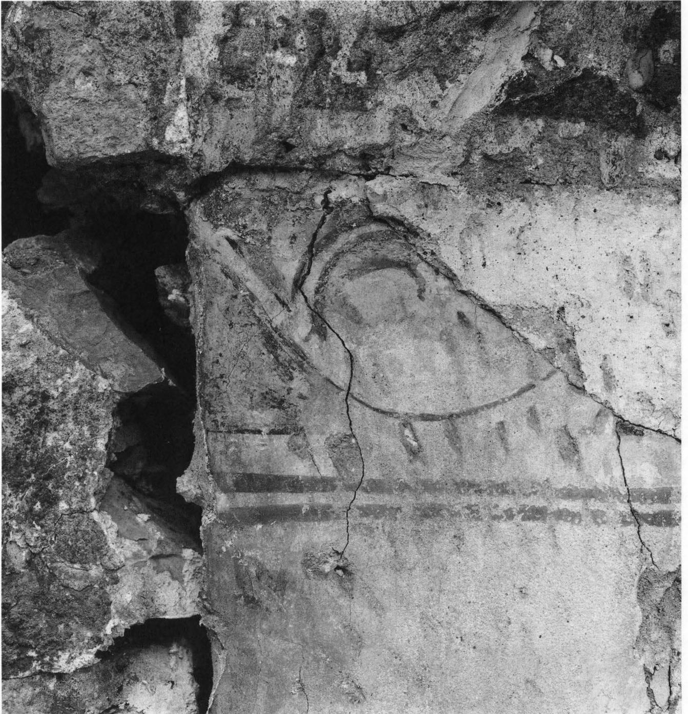
Abb. 5. Detailansicht des Originalverputzes an der Südwand unter dem Dach. Die Mörtelkrusten und -abdrücke belegen, dass der Verputz seitlich (links) an die ehemalige Stadtmauer und oben horizontal an eine verputzte Bretterdecke anschloss. Der obere Rand schloss mit einem breiten, aus geschwungenen Ranken gemalten Fries ab. Der Doppelstrich (orangerot) darunter gehört zum obersten Quader.
