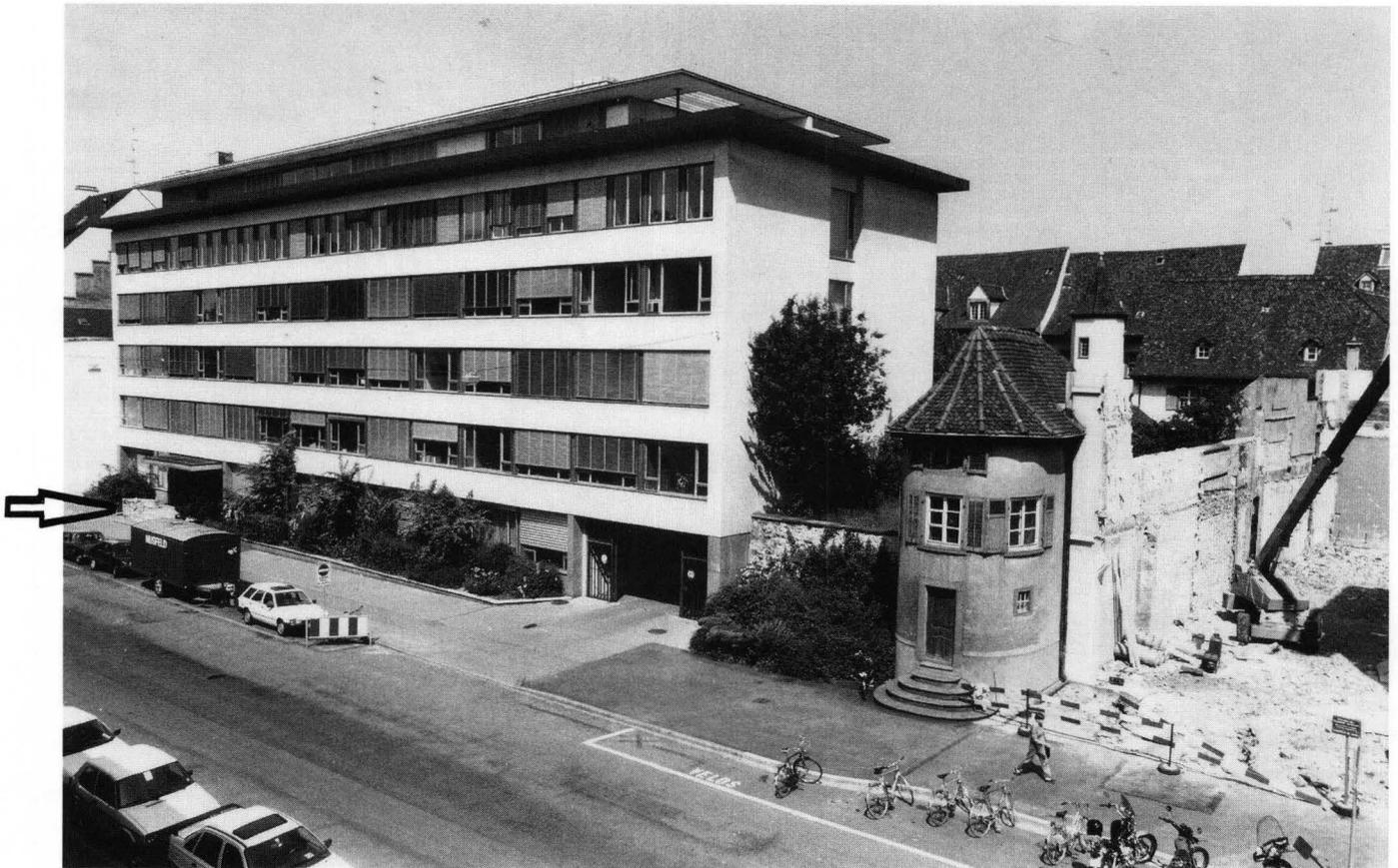
Abb. 2. Der Turm aus dem frühen 14. Jh. am heutigen Petersgraben. Links vom Turm die bis auf Gartenniveau abgetragene Innere Stadtmauer. Das kleine Fenster in der Mitte unter dem Dach ist noch – abgesehen vom Gewände – die einzige originale Öffnung des Turms. Die übrigen Fenster sowie die Türe wurden im 18. und 19. Jh. eingebaut.
