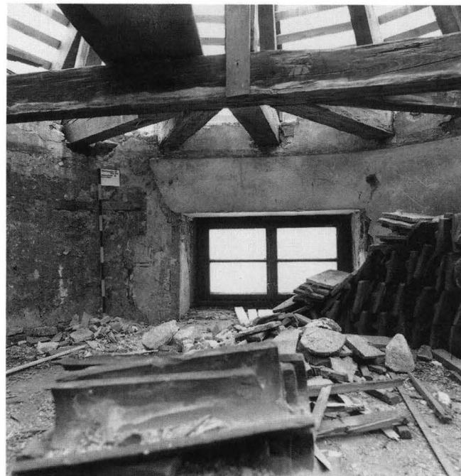
4b. Über der originalen Fensteröffnung fächert die Bundbalkenlage des Dachstuhls von der runden Schalenmauer mittels eingewechselter Stichbalken zur polygonalen Abwalmung auf. Die Sturzhöhe über dem Fenster markiert ca. die Aufhöhung des Turms bei der Errichtung des neuen Dachstuhls (14./15. Jh.).
