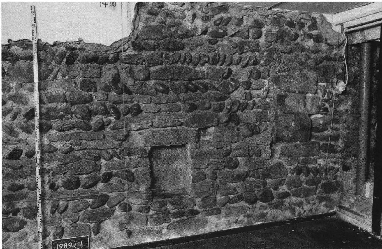
Abb. 7. Phase 2: Blick nach Nordosten auf die Aussenwand von Kernbau I (Erdgeschoss) mit den beiden Nischen (die Nische rechts ist zugemauert). Hinter der Abwasserleitung sind noch Reste von Fugenstrich erhalten (vergleiche Anhang B). – Foto: AB, Nr. 26.
