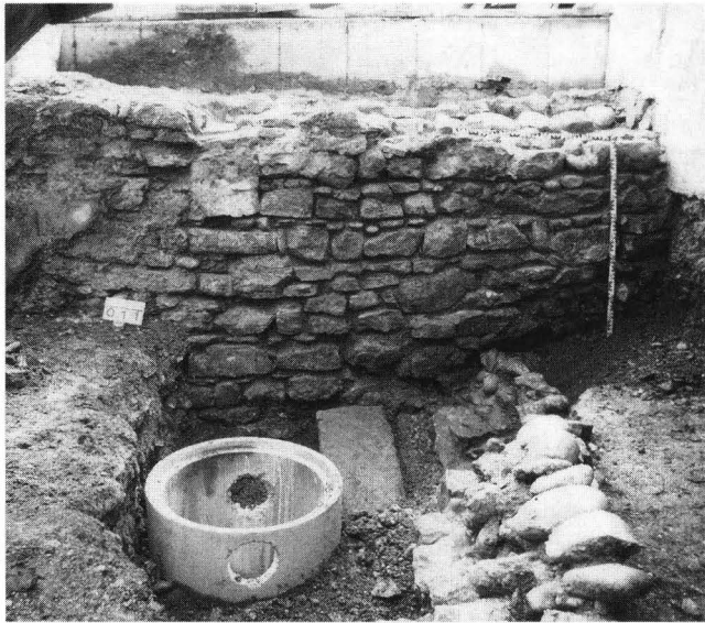
Abb. 4. Blick nach Süden auf Mauer 5a (der neuzeitliche Verputz ist abgeschlagen). Im Vordergrund die schräge Abbruchkante von Mauer 4. Bei der Steinplatte rechts hinter dem modernen Wassersammler handelt es sich um die unterste Stufe einer neuzeitlichen, auch auf dem Falknerplan eingetragenen Treppe (fehlt auf dem Foto, da bereits abgebrochen).
