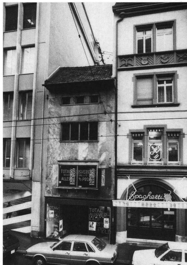
Abb. 2. Blick auf die ehemalige Hinterfassade des Hinterhauses an der Falknerstrasse Nr. 29 (Bildmitte); Zustand vor dem Abbruch. – Foto: AB, Ü 2.
