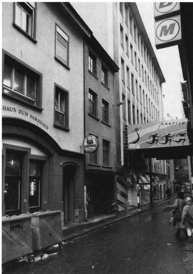
Abb. 1. Blick auf die ehemalige Vorderfassade des Hauses Nr. 14 an der Weissen Gasse (Bildmitte, hinter dem Wirtshausschild); Zustand vor dem Abbruch. – Foto: AB, Ü 5.
