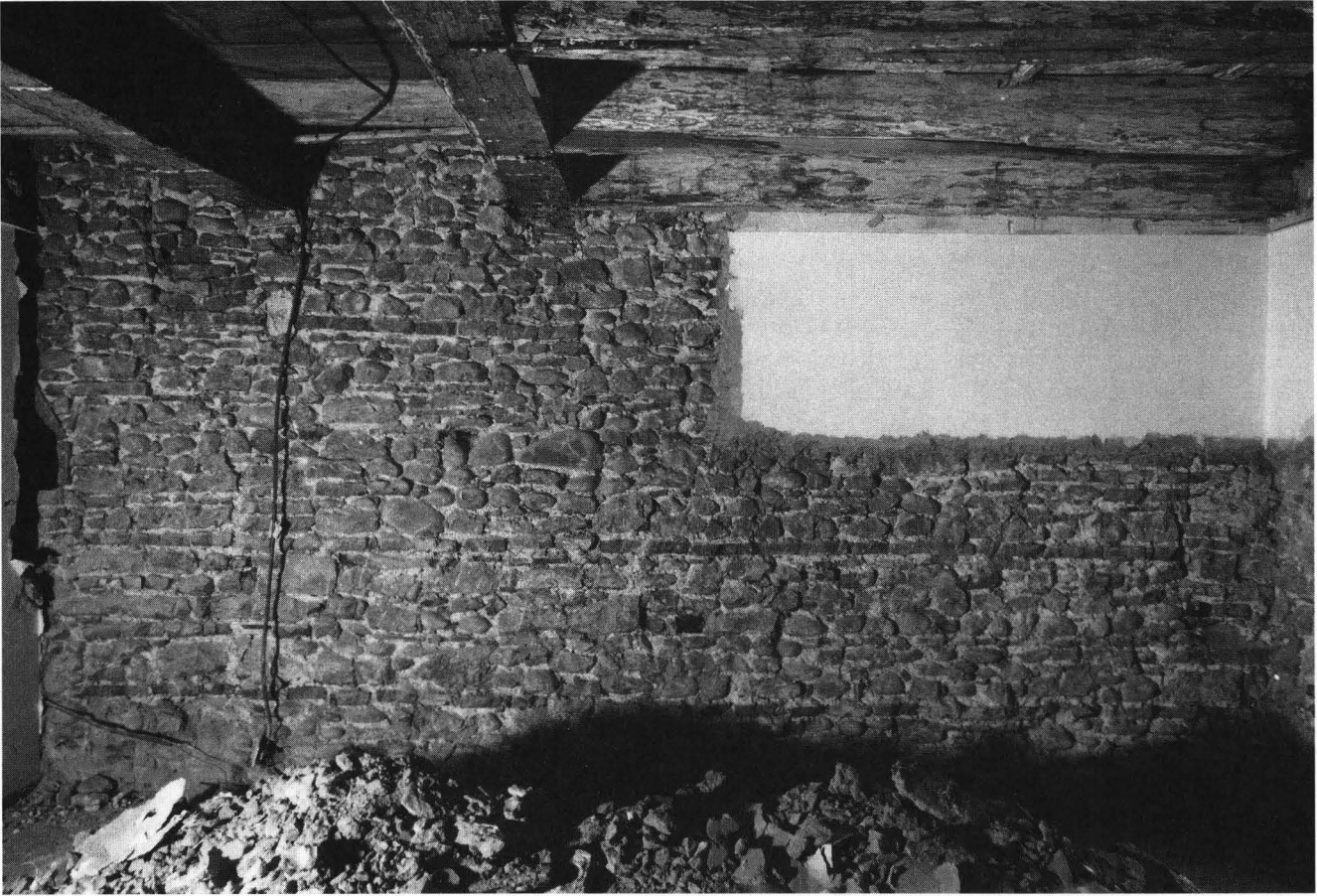
Abb. 14. Phase 5: südliche Brandmauer im 3. Obergeschoss, Erweiterung von Kernbau I gegen die Weisse Gasse zu (Aussenseite). Der Mauercharakter mit den horizontalen Backsteinbändern ist deutlich verschieden (jünger) von dem der Kernbauten. Die mit Backsteinen gefassten, spitzgiebligen Wandnischen bezeugen, dass diese Mauer räumlich von Anfang an von dieser Seite her erschlossen war (siehe Anhang C). – Foto: Basler Denkmalpflege, 256-36.
