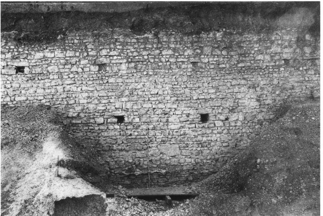
Abb. 9. Rückseite der Kontermauer (vgl. gezeichneter Mauerausschnitt in Abb. 7).
