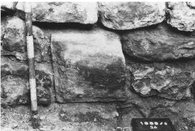
Abb. 8. Bossenquader in Zweitverwendung, eingemauert in die Mauerfront der Inneren Stadtmauer (siehe Abb. 6,A und 7a).
