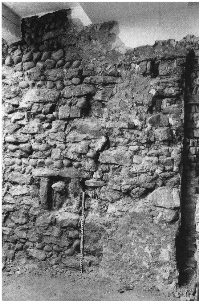
Abb. 13. Phase 3: Wandnische in der Südmauer von Kernbau II. Sie ist nahe der südwestlichen Hausecke im 1. Obergeschoss original eingelassen. Form und Fassung der Nische sind ähnlich wie jene von Kernbau I (Abb. 7, Anhang D: d). – Foto: Basler Denkmalpflege, 256-29.
