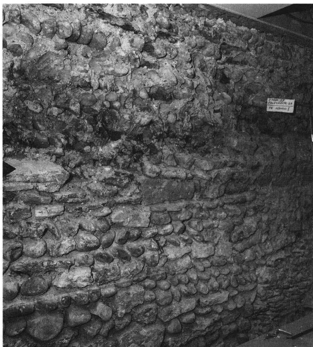
◀ Abb. 11. Phase 3: Innenansicht der Südmauer von Kernbau II im Erdgeschoss. Die freigelegte Mauer, an deren westlichem Ende die birsigseitige Türe eingelassen ist (Abb. 10), lässt den Ansatz des abgebrochenen Gewölbes anhand einer Lage schräg gestellter Steine (Pfeile im oberen Bildmittel) erkennen. – Foto: Basler Denkmalpflege, G 224-7.
