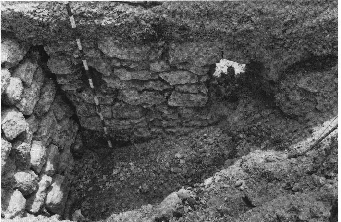
Abb. 9. Ansichten des Schalenturms. – 9a. Aussenseite des Schalenturms, der mit einer deutlichen Stossfuge an die Stadtmauer (links) anschliesst.
