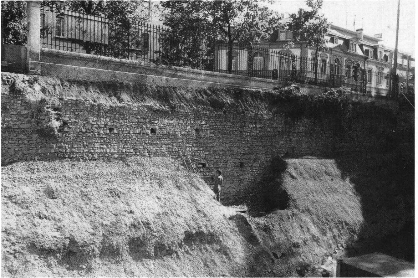
Abb. 8. Baugrubenböschung mit Kontermauer (Rückseite). Im Hintergrund ist der Steingraben zu erkennen.
