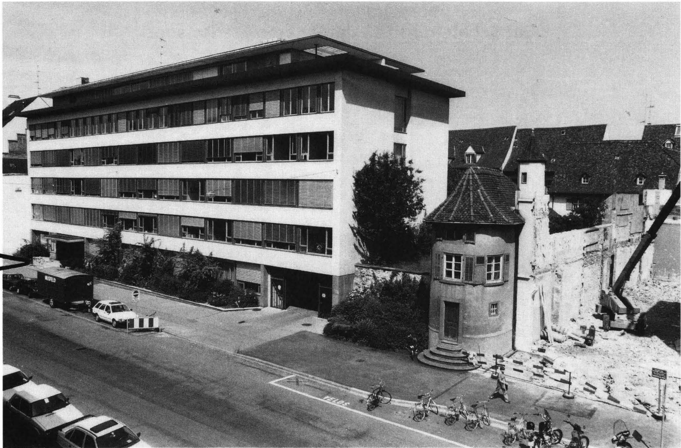
Abb. 1. Petersgraben 35, 43 und 45. Überblick: am rechten Bildrand liegt die Baustelle Petersgraben 45 mit den Fundamenten eines mittelalterlichen Stadtmauerturms, unmittelbar links davon der Schalenturm Petersgraben 43 und am linken Bildrand (Pfeil) sind im Vorgarten Petersgraben 35 die konservierten Reste eines weiteren Schalenturms zu erkennen.
