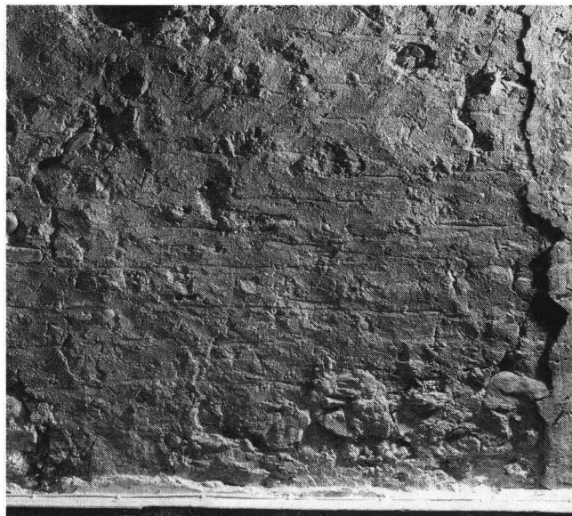
Abb. 8. Phase 2: Mauerfläche mit horizontalem Fugenstrichverputz im 2. Obergeschoss. Es handelt sich um die ursprüngliche, südliche Giebelfassade des Kernbaus I (Aussenseite). – Foto: Basler Denkmalpflege, B 252-34.
