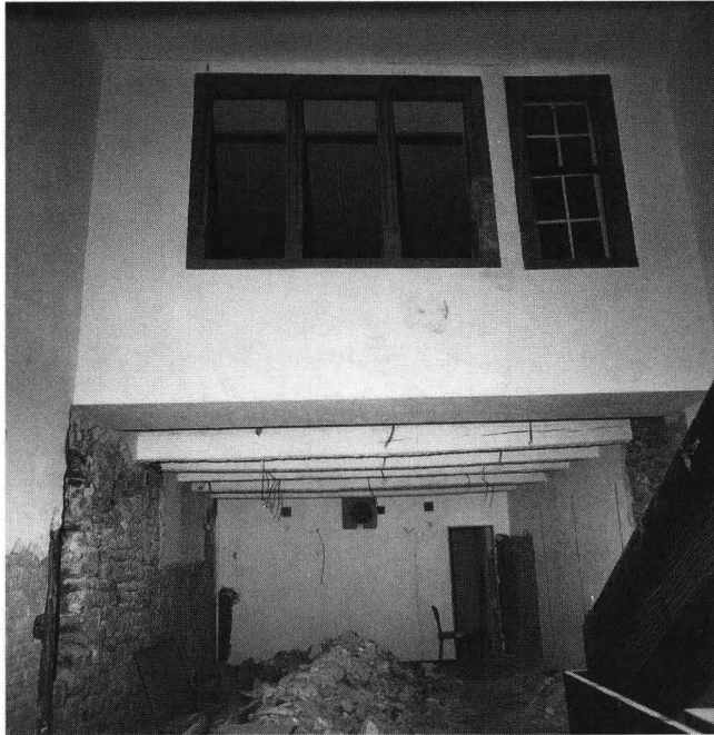
Abb. 5. Phase 5: Hoffassade des Hauptbaus. Die Fassade im 2. Obergeschoss überspannt die gesamte Hausbreite. Sie ist anlässlich der gassenseitigen Erweiterung von Kernbau II entstanden. Beim modernen Ladenumbau wurde der untere Teil der Hoffassade abgebrochen und der obere Teil mit Stahlträgern aufgefangen. – Foto: Basler Denkmalpflege, G 225-10.
