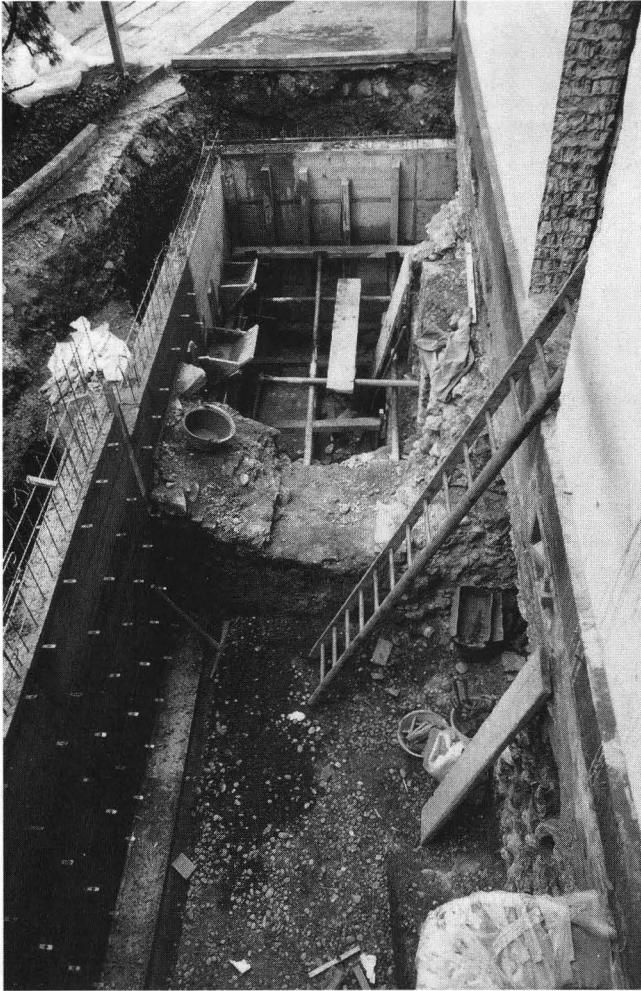
Abb. 6. Petersplatz 10, 1987/39. Blick von Süden auf die freigelegten Fundamente des Schützenmättleinturmes (Abb. 10,10) innerhalb des neuen Treppenhauses und des «Technikkellers».
