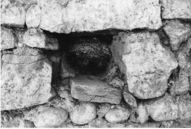
Abb. 10. Detail: Gerüsthebellöcher. Deutlich ist unten das runde Mörtelbett des Gerüstholzes und dahinter ein das Loch verstopfender Mörtelpfropfen zu erkennen.
