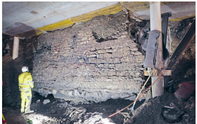
**ABB. 26** Nur dank des Einsatzes von Kompressor und Druckluftlanze gelang es, die grossen Mauerflächen speditiv freizulegen. Foto: Birgit Lißner.
