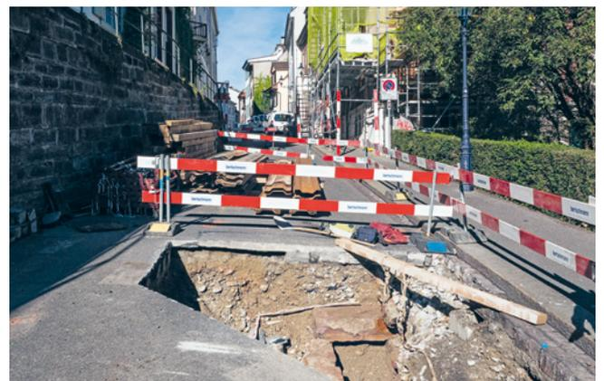
**ABB. 25** Blick stadteinwärts, den Mühlberg hinauf. Unten rechts, neben dem Trottoirrand, ist der aufgedeckte Dolenkanal sichtbar. Foto: Martin Allemann.
