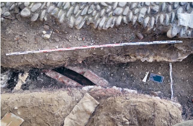
**ABB. 14** Unter der Kieselpflasterung und modernen Aufschüttungen ist der aus Backsteinen gemauerte Kanal zu erkennen, links und rechts begleitet von einer schmalen Baugrube. Foto: Michael Weber.
