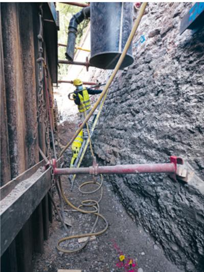
ABB. 6 Ein Stück der Aussenschale der freigelegten Inneren Stadtmauer wird vor der Dokumentation mit einer Druckluftlanze geputzt.
