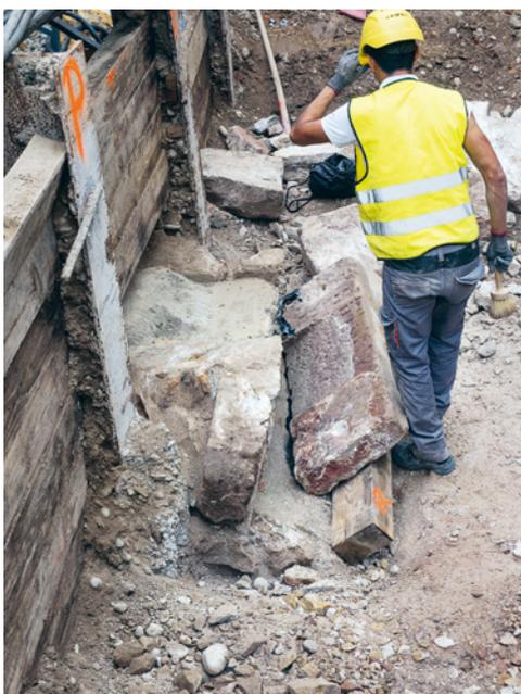
ABB. 17 Mit dosiertem Einsatz schwerer Werkzeuge gelang es, die Grabsteine unbeschädigt aus dem angeschnittenen Gewölbe (unten links) auszubauen, in das sie eingemörtelt waren. Foto: Martin Allemann.
