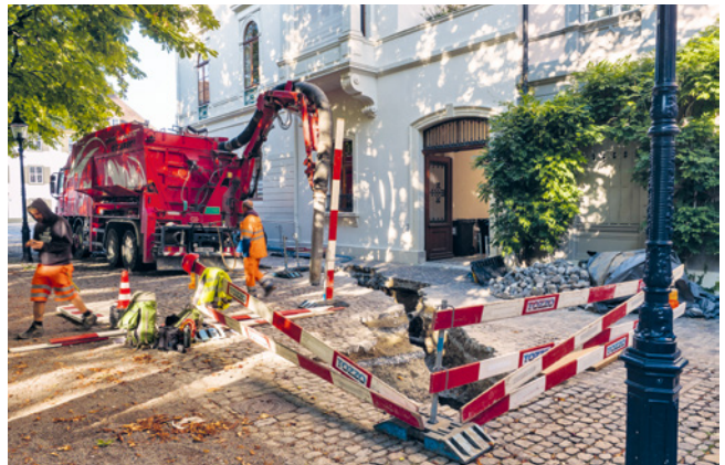
ABB. 5 Der Saugbaggeraushub vor dem Münsterplatz 2–4 konnte an archäologischen Schichten vorbei dirigiert werden. Foto: Fabian Bubendorf.
