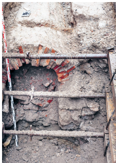
ABB. 38 In der Eisengasse fanden sich Reste eines Backsteingewölbes, das zu einer Kanalisation des 19. Jahrhunderts gehörte. Foto: Fabian Bubendorf.
