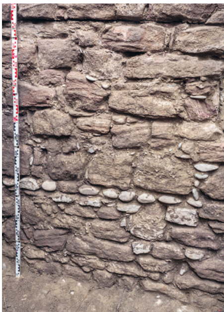
ABB. 19 Das sorgfältig ausgeführte Mauerwerk der Kontermauer: Sichtbar ist der obere Bereich der Mauer; sie dürfte noch weitere 4 m bis zur Sohle des Stadtgrabens in den Boden reichen. Foto: Adrian Jost.
