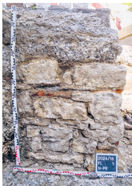
ABB. 44 Unter der Strassenpflasterung hat sich der Rest einer alten Kellermauer aus dem 19. Jahrhundert erhalten. Foto: Michael Ketzler.
