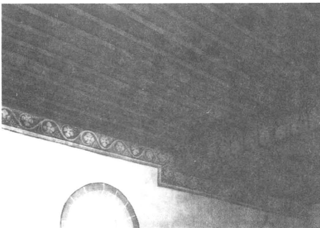
Abb.96. Restaurierte Decke im Bereich der Nordwand des fünften und sechsten Joches des Mittelschiffs. - Foto: P.Denfeld.
