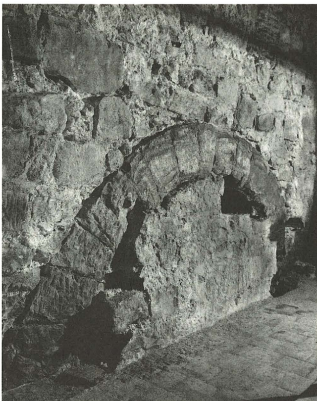
Abb. 12. Dorfkirche, 1942/1. Detailaufnahme: oberer Teil des westlichen Bogens in der Nordfassade der Kirche, romanisch. - Foto: Spreng, SWB, Basel.
