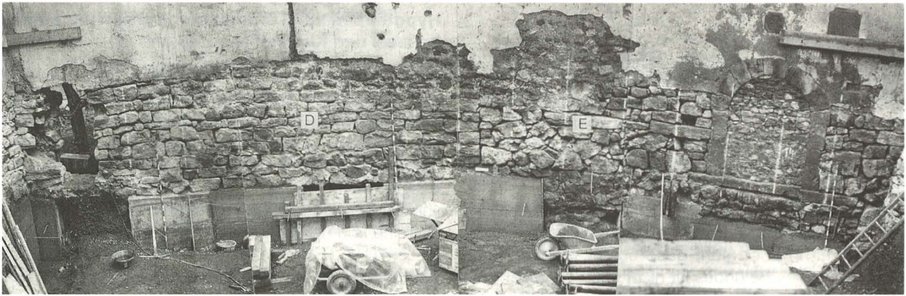
Abb. 44. Meierhof, 1973/26. Ansicht der Trennmauer Kirchhof - Meierhofareal, von Süden. - Foto: AB.
