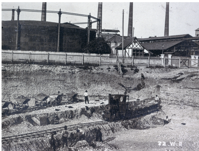
Abb. 5 Für das Fundament des 1911 erbauten Gaskessels musste tiefgreifend Kies ausgehoben werden. An der Baugrubenwand lassen sich grosse Eintiefungen bzw. Gruben erkennen. Im Hintergrund sind die alte Gasfabrik und Fabrikgebäude zu sehen.
