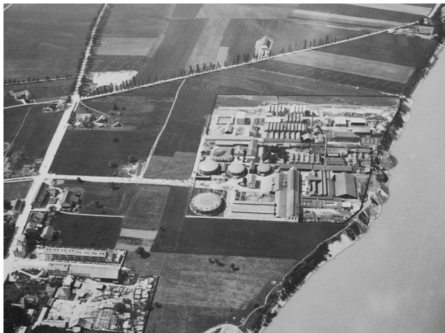
Abb. 1 Ballonaufnahme von 1895 des Gaswerks im Bereich der Fundstelle Basel-Gasfabrik.
